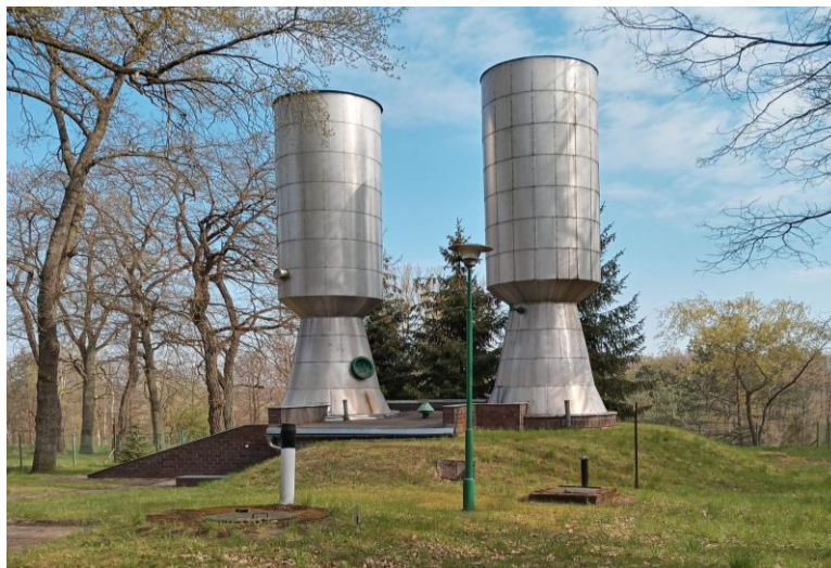
Stacja Uzdatniania Wody w Nietkowie Fot. PSSE Zielona Góra
