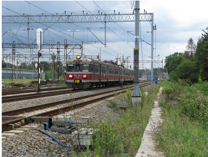
Fot. 5. Wodzisław Śl. RB2, linia kolejowa nr 158 w kierunku Chałupek.
