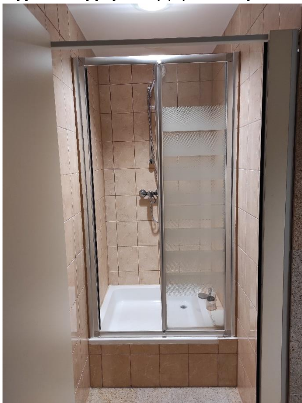
Zdjęcia istniejącej kabiny prysznicowej:
