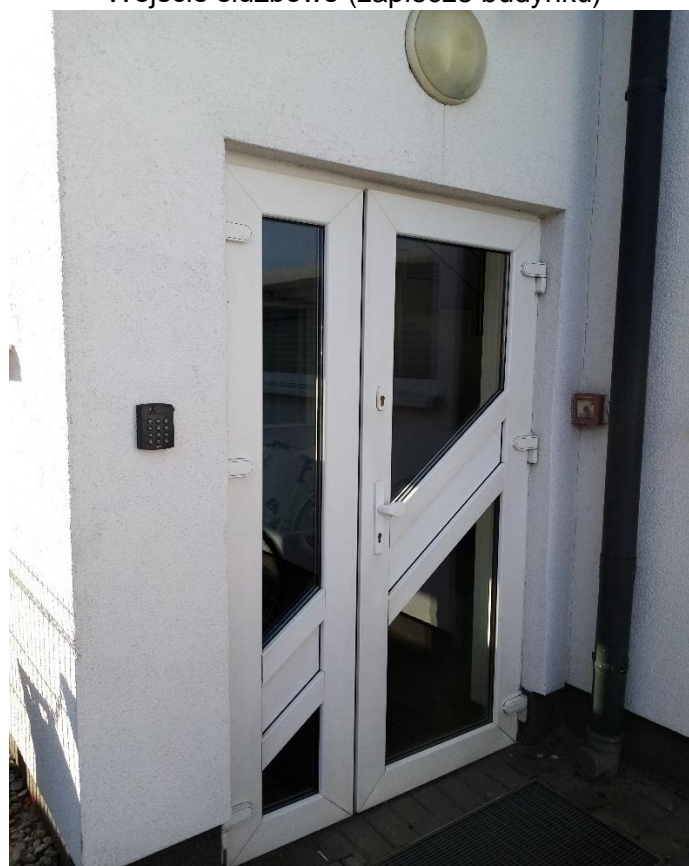
Wejście służbowe (zaplecze budynku)
