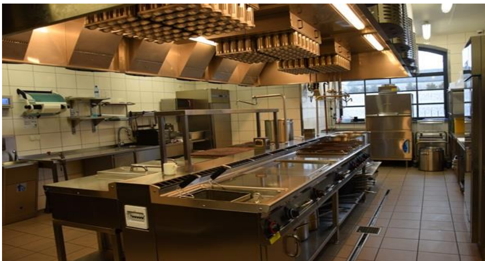
Rys. 10. Pomieszczenie kuchenne dużego zakładu gastronomicznego
