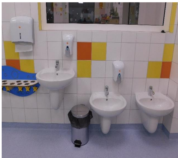
Rys. 7. Pomieszczenie sanitarne w Gminnym Żłobku w Trzcince
