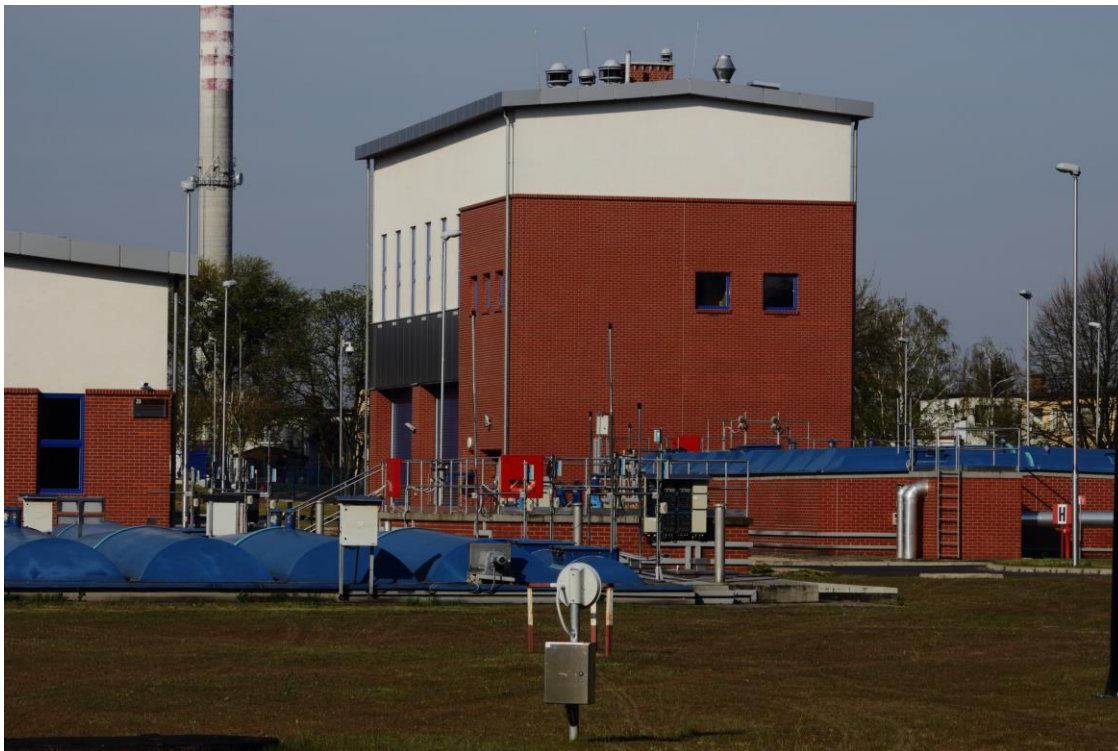
Rys. 6. Stacja Uzdatniania Wody w Mosinie
