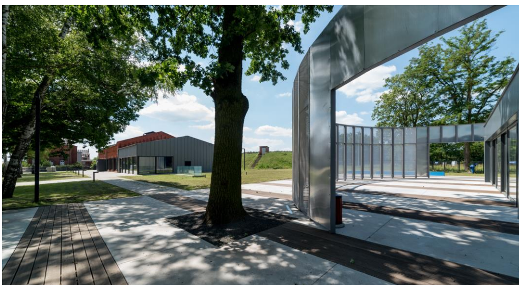
Rys. 2. Stacja Uzdatniania Wody w Zaborowie i Centrum Edukacji Ekologicznej (wodociąg publiczny Leszno – raportowany do Komisji Europejskiej)
