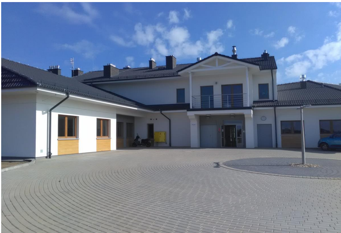
Rys. 12. Poradnia Opieki Paliatywnej – hospicjum domowe przy ul. Królewskiej 8 w Pile
