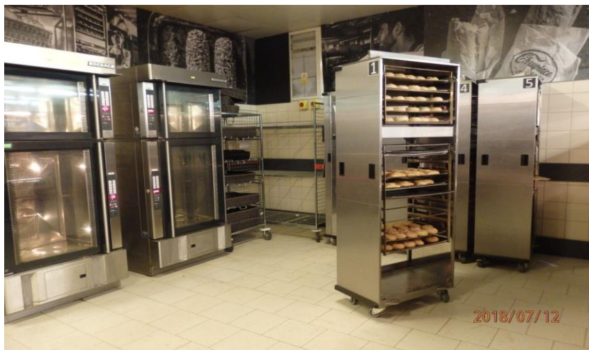
Rys. 7. Stanowisko wypieku pieczywa w jednym z dyskontów – piece do wypieku pieczywa
