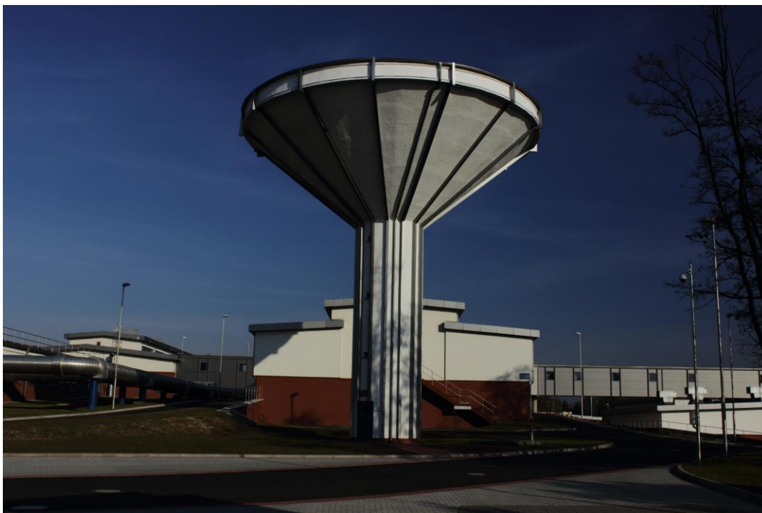
Rys. 7. Stacja Uzdatniania Wody w Mosinie
