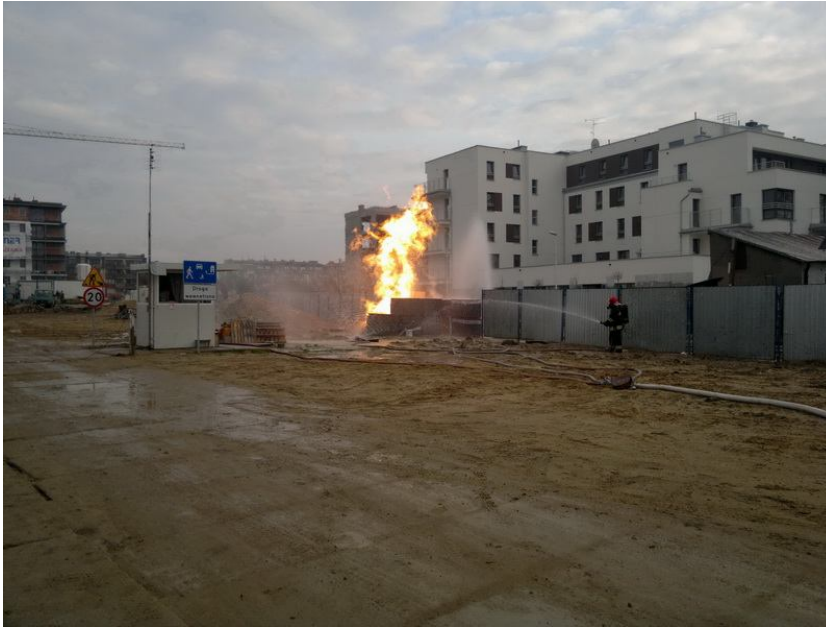
Pożar gazociągu średniego ciśnienia przy ulicy Siennickiej
