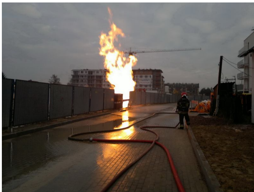
Pożar gazociągu średniego ciśnienia przy ulicy Siennickiej
