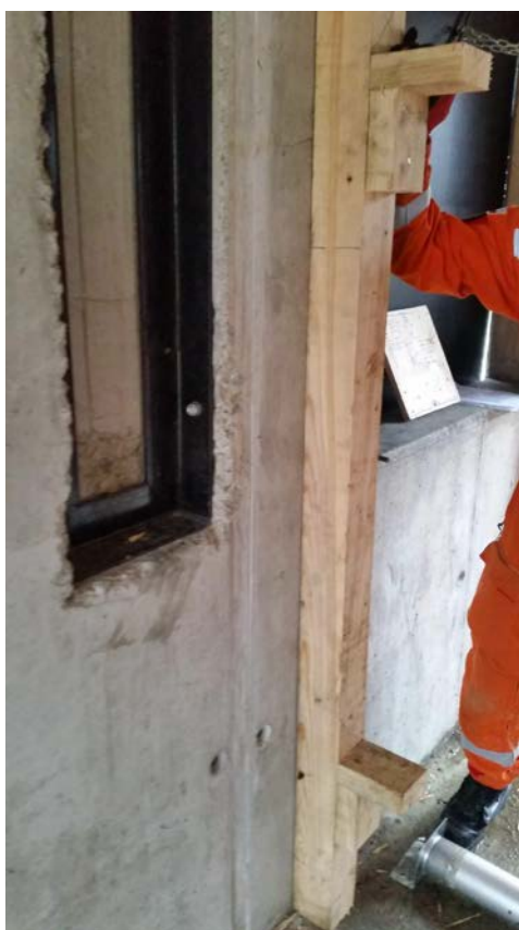
Fot. 71. Ustawienie belek przyściennych
