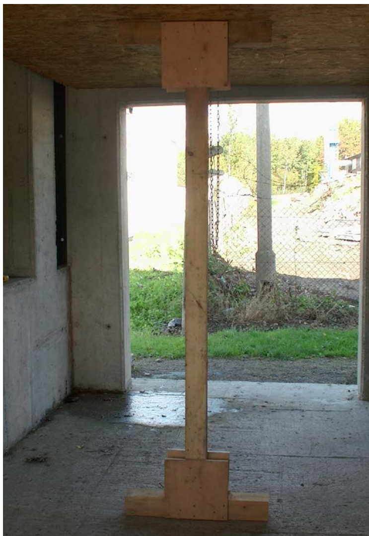
Fot. 26. Podpora pionowa typu „T”
