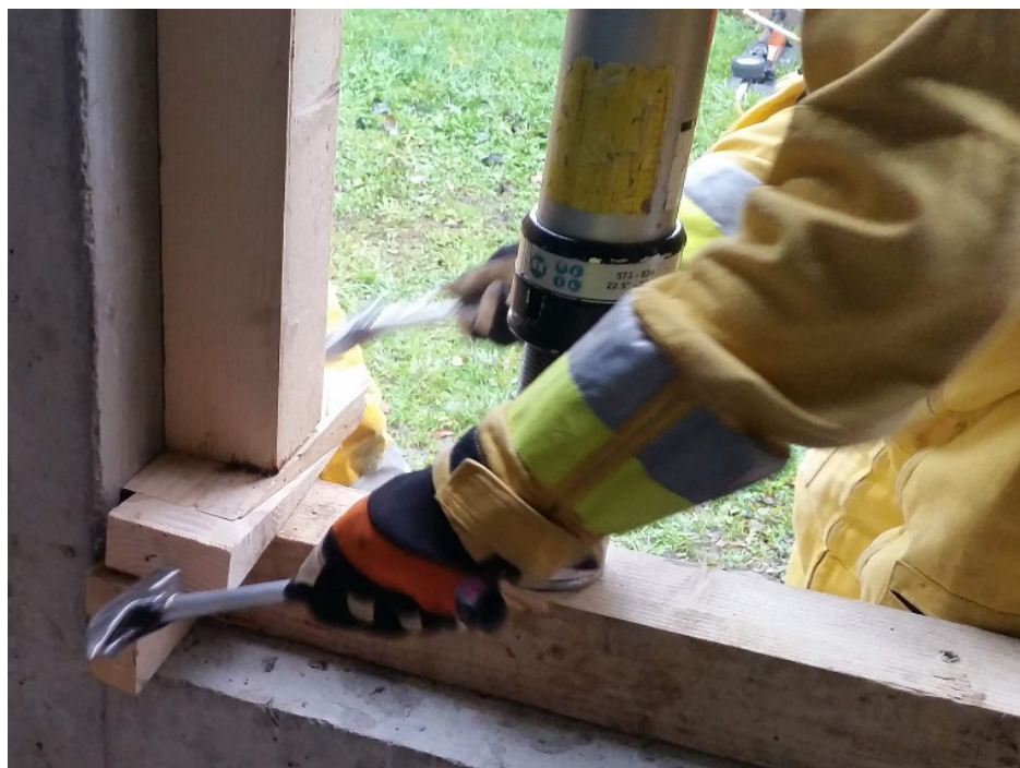
Fot. 51. Umieszczenie słupa i dobicie klinów
