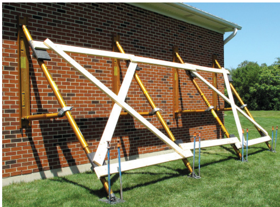
Fot. 19. Podpora ukośna wykonana z czterech podpór, stężona przy pomocy elementów drewnianych
