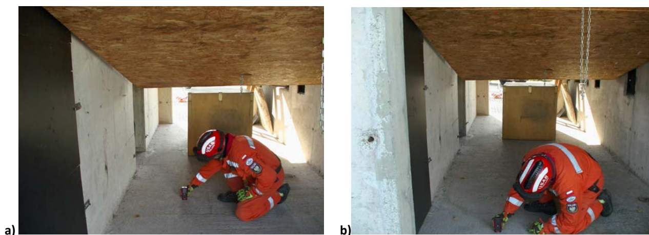
Fot. 65. a) i b) Wykonanie pomiaru przy pomocy dalmierza laserowego
