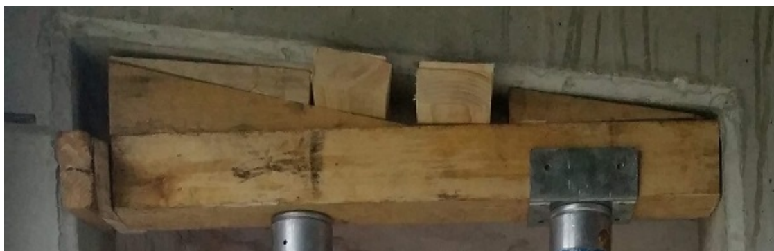
Fot. 57. Wypełnienie pustych przestrzeni
