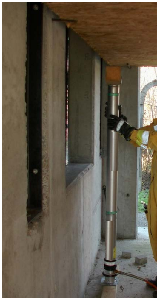
Fot. 28. Montaż pionowej podpory tymczasowej typu „T”
