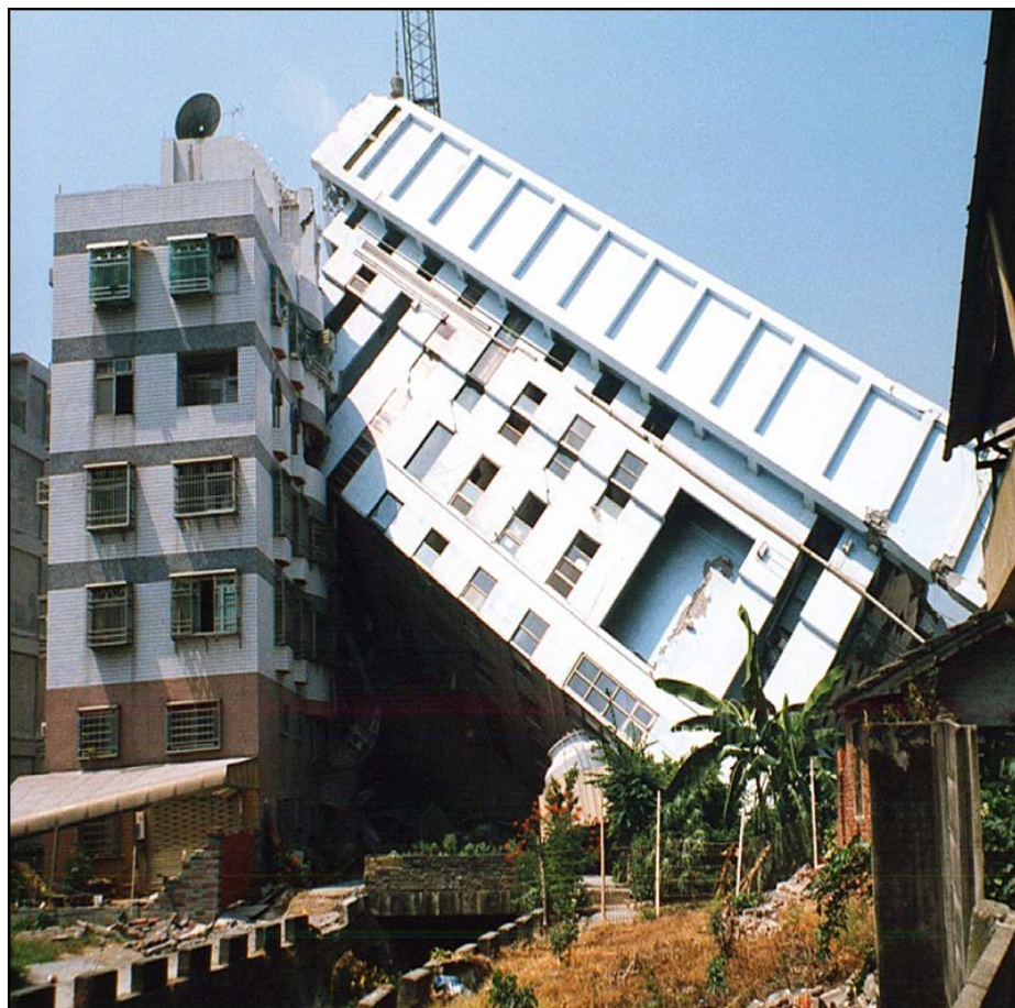
Fot. 2. Zawalenie typu „przemieszczenie boczne”
