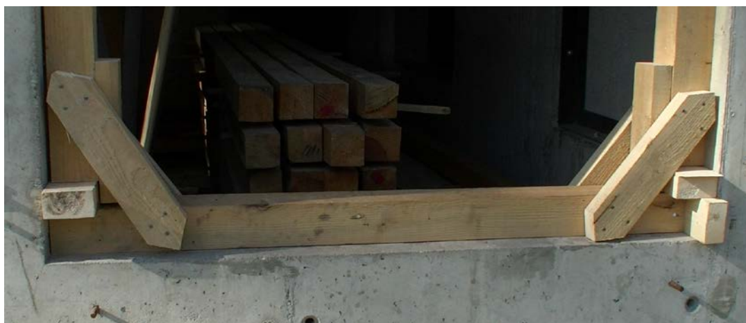
Fot. 54. Stężenie słupa z podwaliną przy użyciu elementu drewnianego
