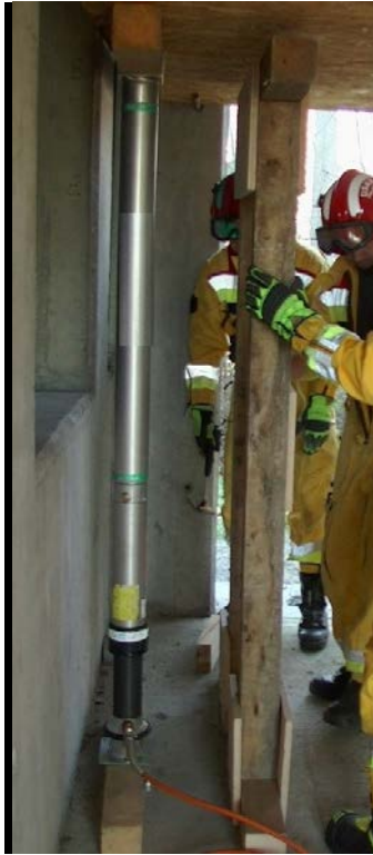
Fot.30. Ustawienie podpory w miejscu stabilizacji
