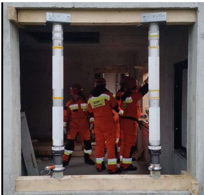
Fot. 49. Zamontowane podpory tymczasowe
