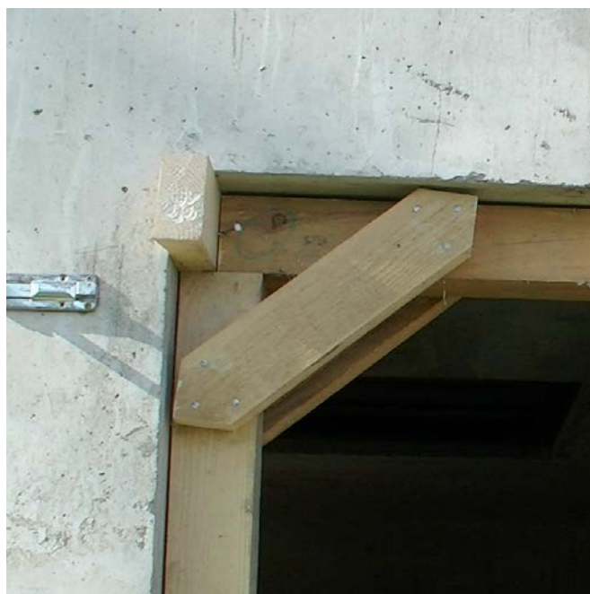
Fot. 53. Stężenie słupa z podciągami przy użyciu elementu drewnianego
