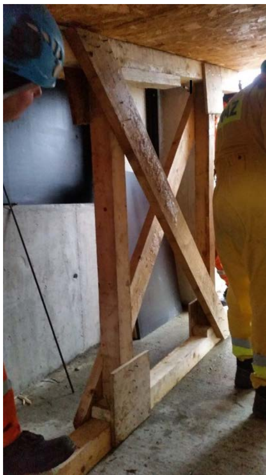
Fot. 68. Podpora zabezpieczająca strop pochyły, wiszący klasy 2
