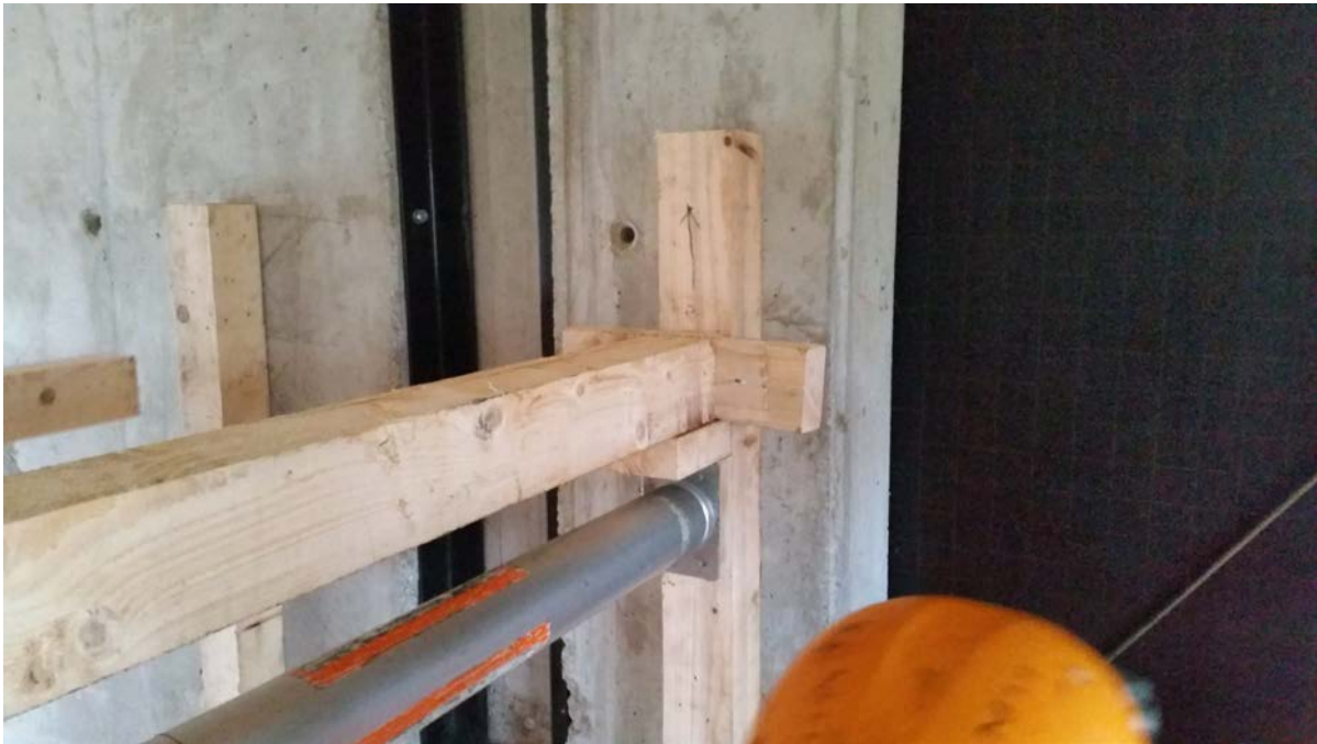
Fot. 74. Zabezpieczenie rozpory drewnianej na belce przyściennej klinami
