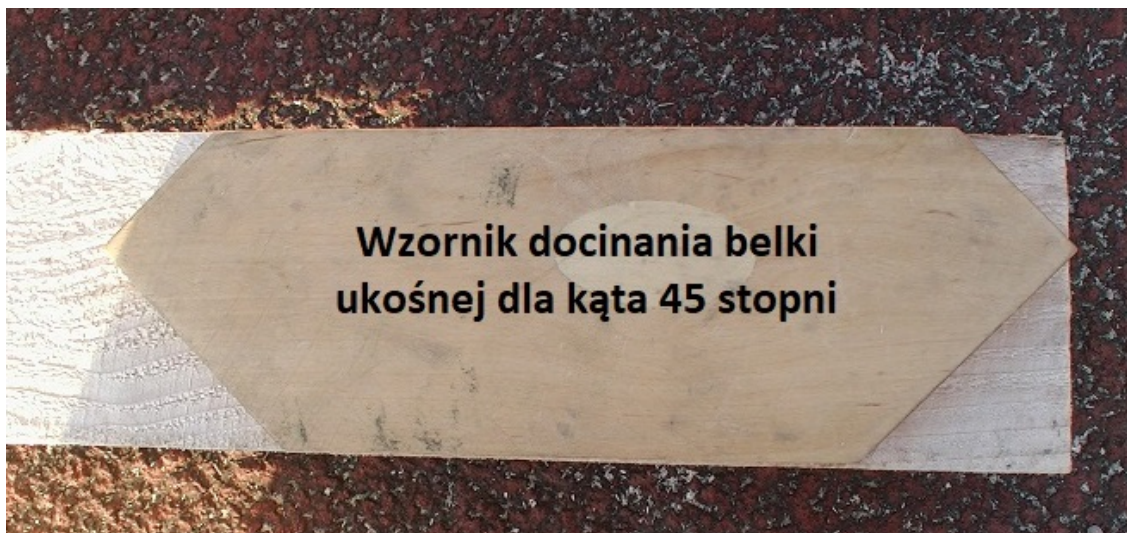
Fot. 84. Wzornik docinania ułożony na belce ukośnej
