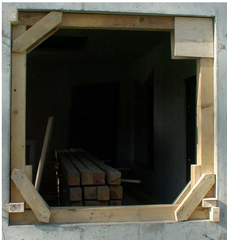
Fot. 55. Podpora zabezpieczająca otwory okienne i drzwiowe typu „budowana w miejscu”
