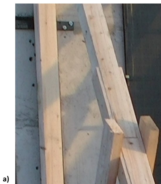
Fot. 89. a) i b) Sposób wykonania belki ukośnej z dwóch elementów
