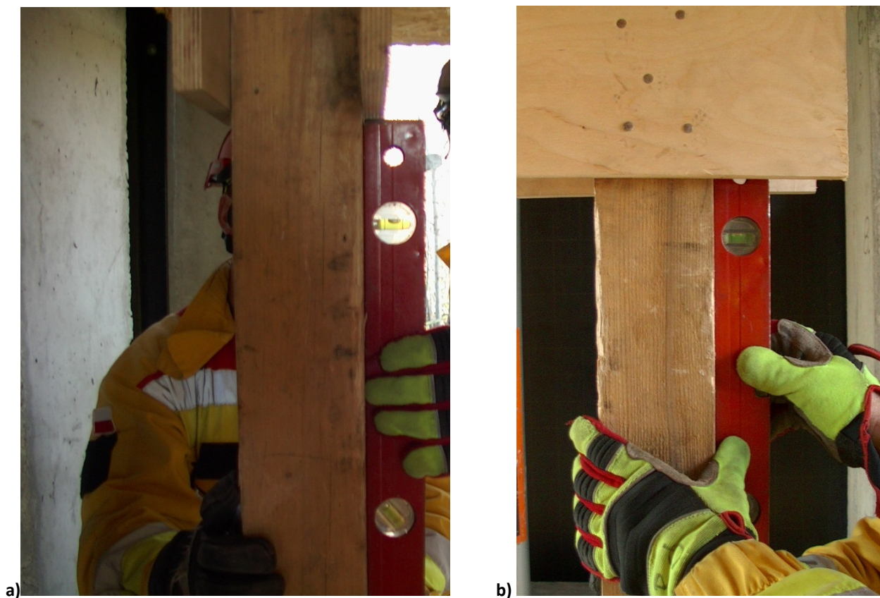
Fot. 25. a) i b) Sprawdzenie prawidłowego ustawienia słupa
