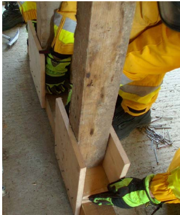
Fot. 31. Wstawienie klinów pomiędzy podwaliną a słupy
