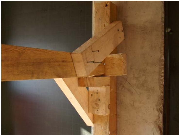
Fot. 76. Stężenie rozpory z belką przyścienną
