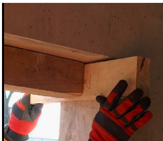
Fot. 47. Umieszczenie podciagu oraz klinów w otworze okiennym
