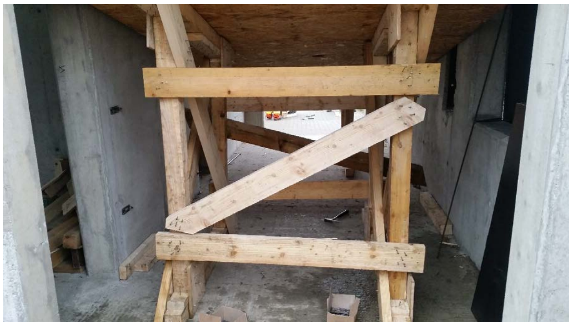
Fot. 69. Podpora zabezpieczająca strop pochyły, wiszący klasy 3
