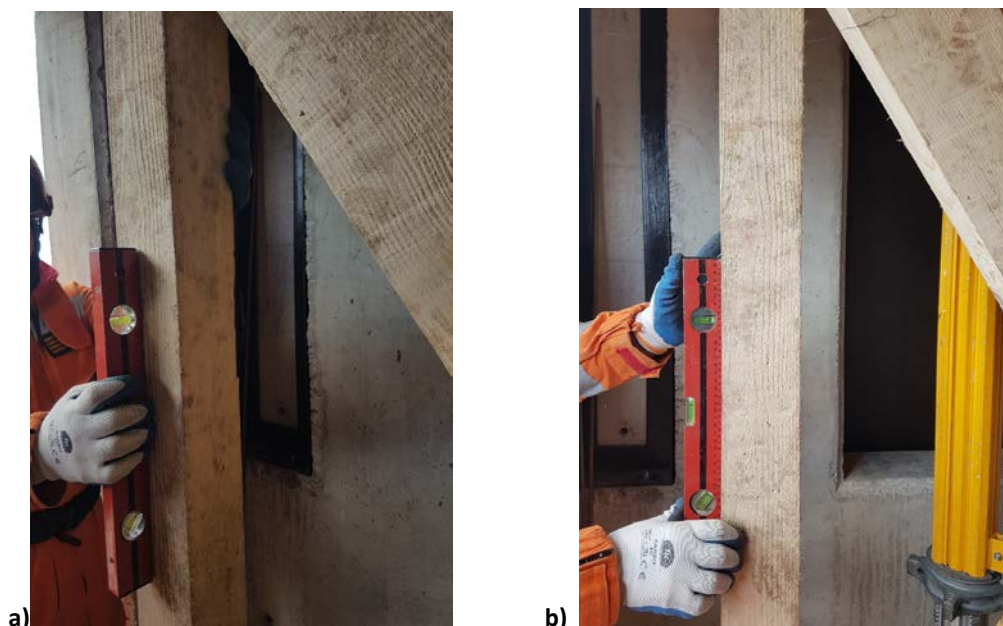
Fot. 37. a) i b) Sprawdzenie prawidłowego ustawienia podpory (Ratownik w rękawicach o niskich parametrach technicznych. Zaleca się stosowanie rękawic o wyższym stopniu ochrony.)
