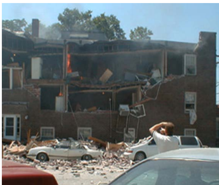
Fot. 1. Zawalenie typu „uszkodzenie po wybuchu”
