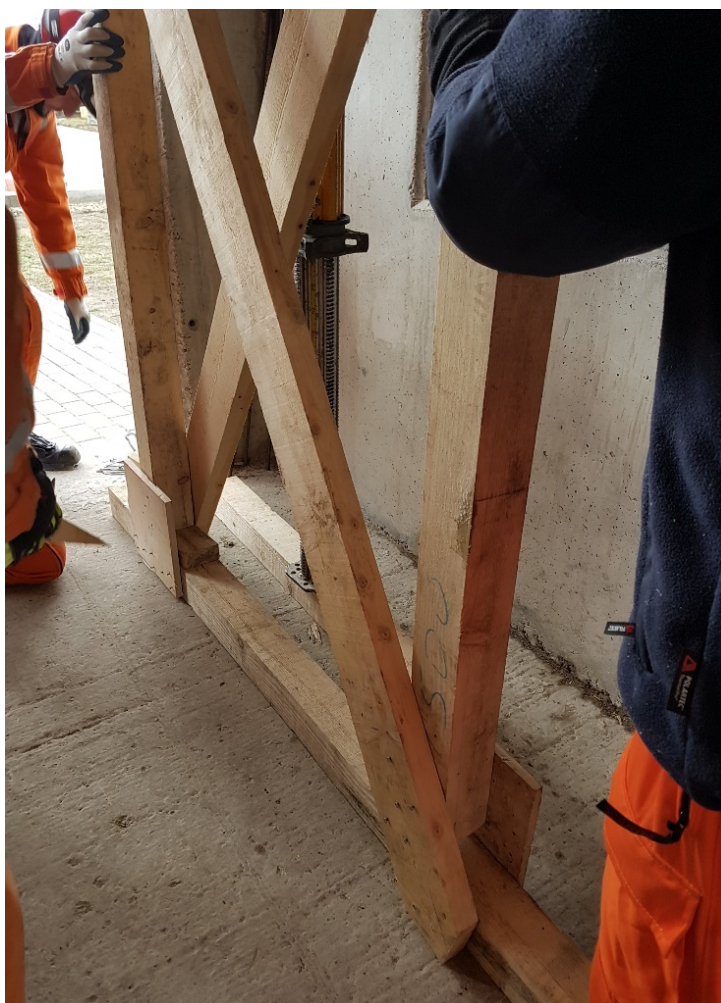
Fot. 36. Ustawienie podpory w miejscu stabilizacji
