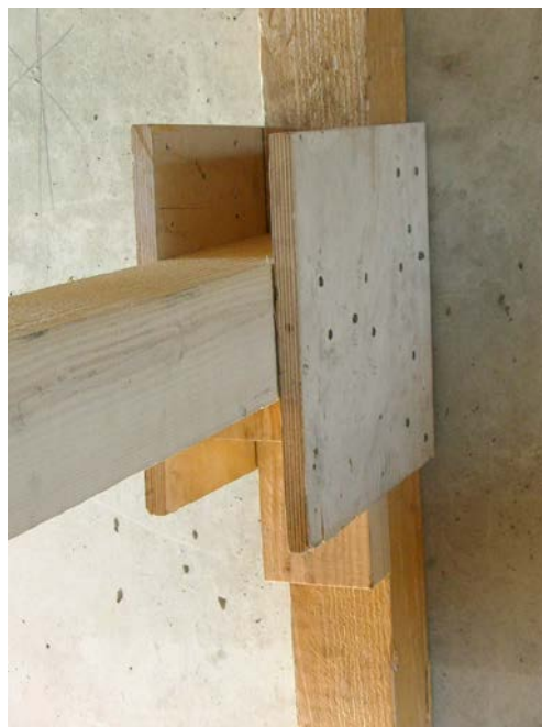
Fot. 75. Łączenie rozpory z belką przyścienną plakiетkami
