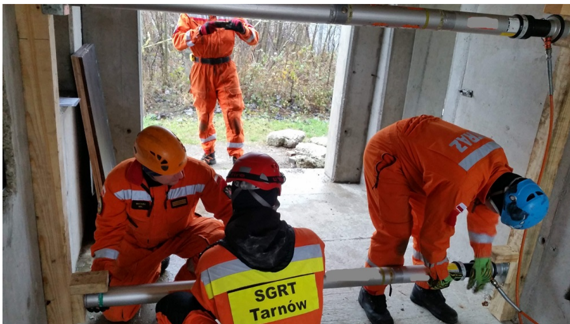
Fot. 72. Umieszczanie rozpory tymczasowej na belkach przyściennych
