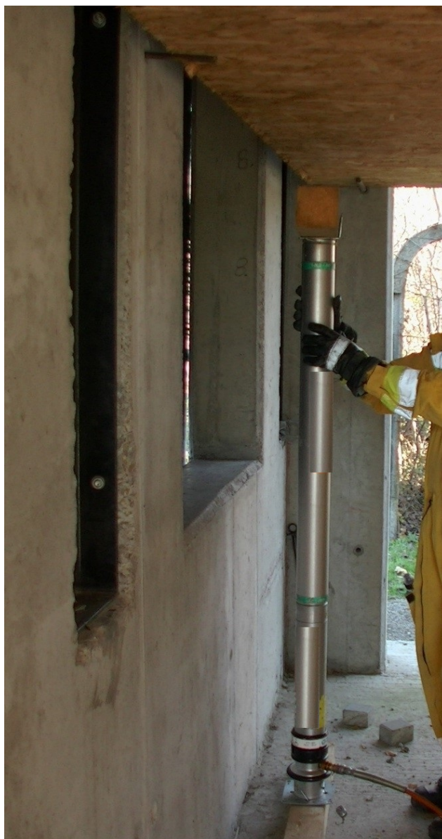
Fot. 24. Montaż pionowej podpory tymczasowej typu „T”
