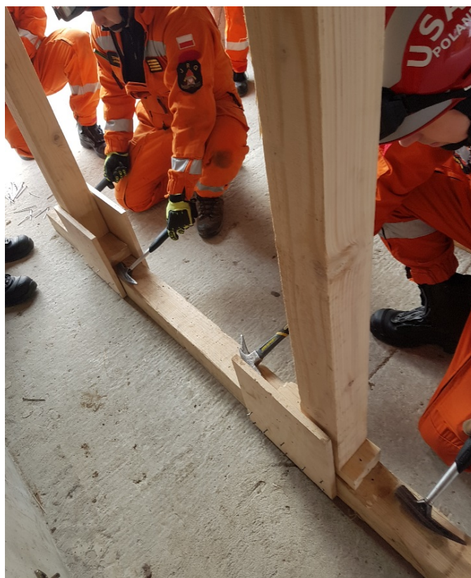
Fot. 44. Usztywnienie podpory poprzez dobicie klinów
