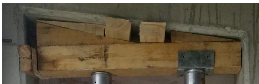
Fot. 50. Wypełnienie pustych przestrzeni
