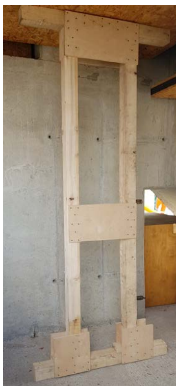
Fot. 33. Podpora pionowa typu „2T”
