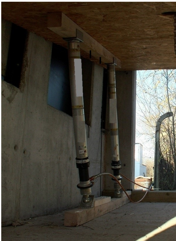
Fot. 62. Ustawiona podpora tymczasowa zabezpieczająca strop pochyły, zakotwiony
