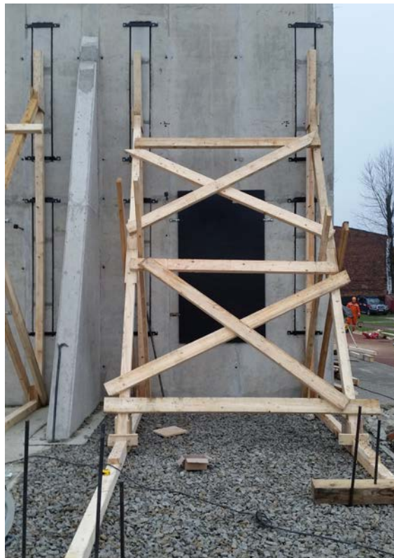
Fot. 90. Podpora ukośna typu – na pełnym trójkącie
