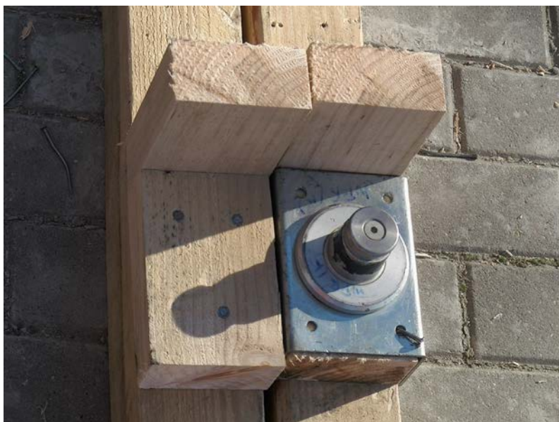
Fot. 70. Belki przyścienne z przymocowanymi podpórkami
