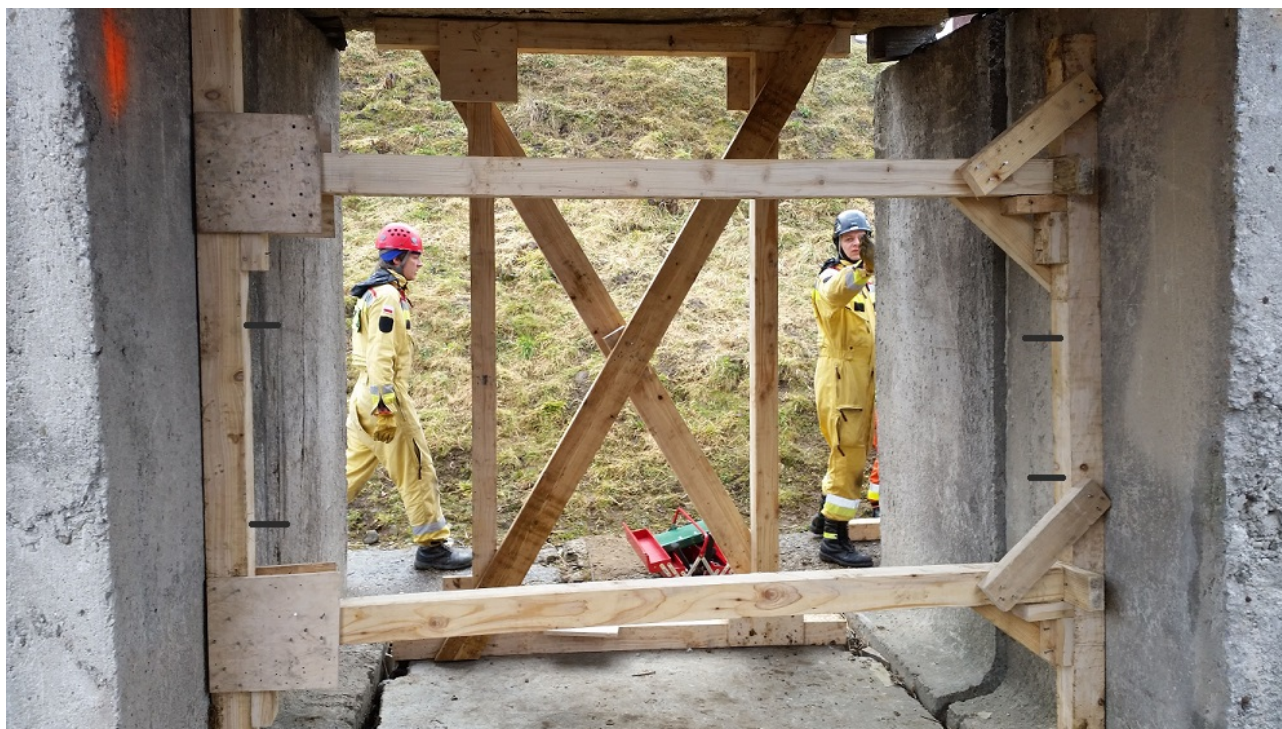
Fot. 78. Przykład podpory poziomej na tle podpory dwu lub więcej słupowej
