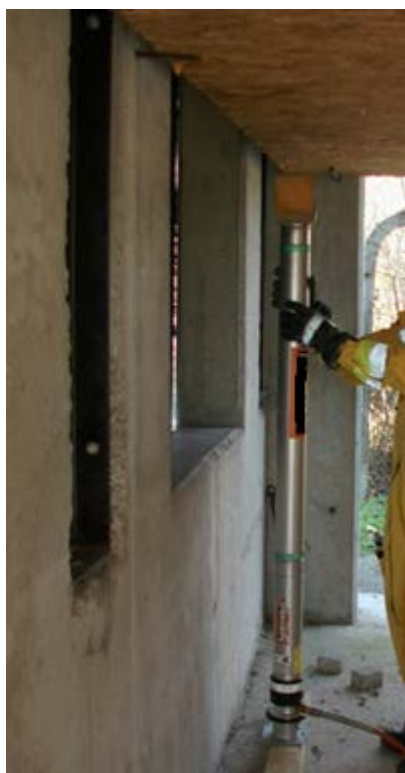
Fot. 35. Montaż pionowej podpory tymczasowej typu „T”
