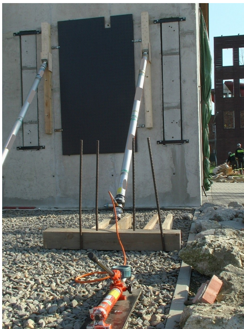
Fot. 82. Ustawiona podpora ukośna tymczasowa typu – wisząca
