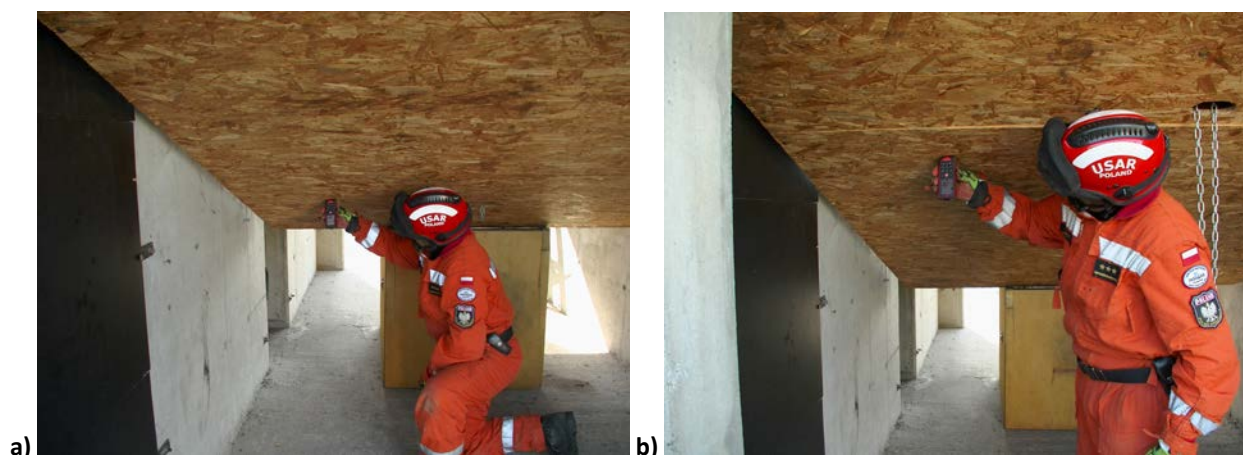
Fot. 59. a) i b) Wykonanie pomiaru przy pomocy dalmierza laserowego
