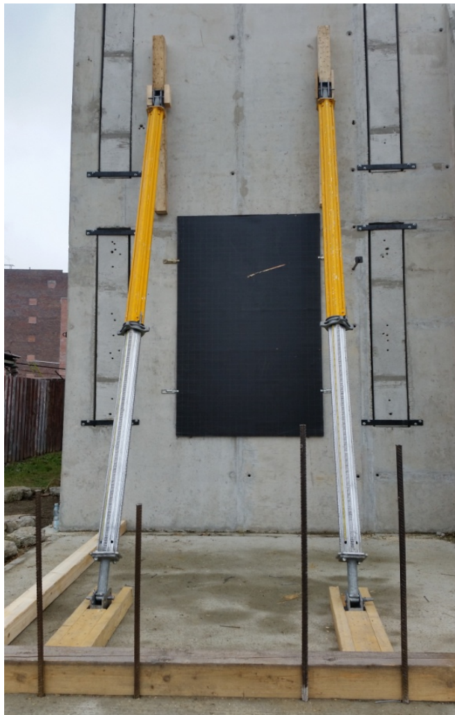
Fot. 22. Tymczasowa podpora ukośna wykonana w systemie podpór budowlanych
