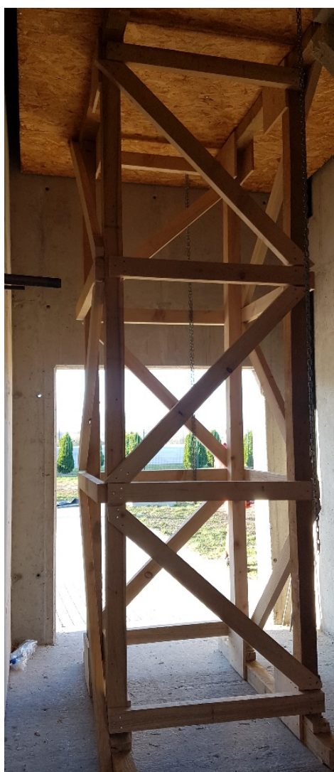
Fot. 45. Podpora pionowa typu „filarowa”
