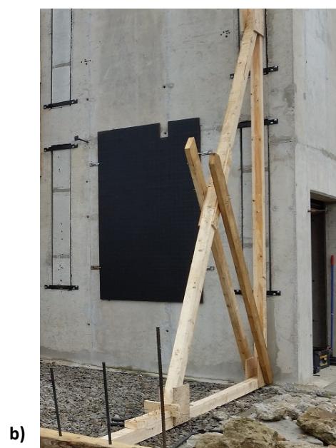
Fot. 89. a) i b) Sposób wykonania belki ukośnej z dwóch elementów
