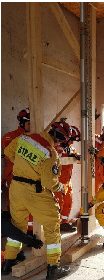
Fot. 42. Montaż pierwszej części podpory
