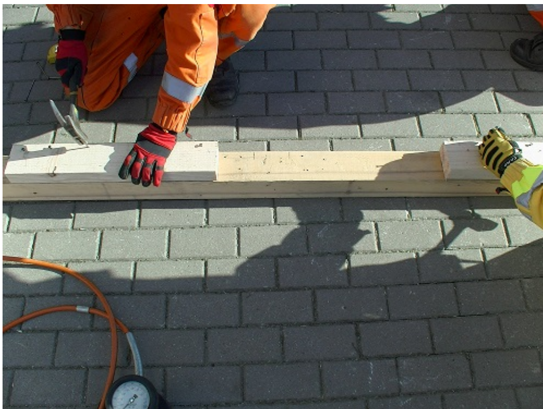
Fot. 66. Podciąg z knagami do podpory zabezpieczającej strop pochyły, wiszący
