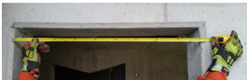
Fot. 56. Wykonanie pomiaru szerokości otworu drzwiowego przy pomocy taśmy mierniczej
