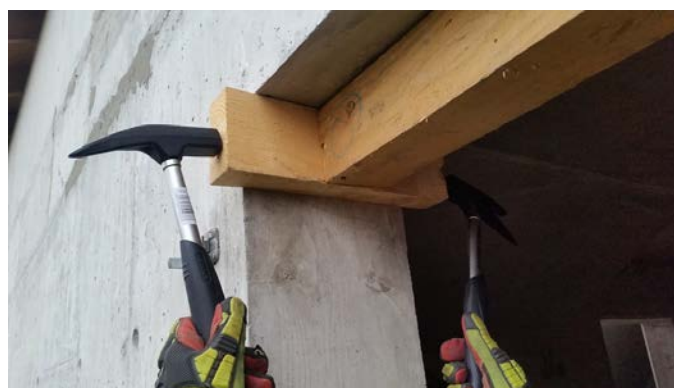
Fot. 48. Sposób wykonania dobicia klinów
