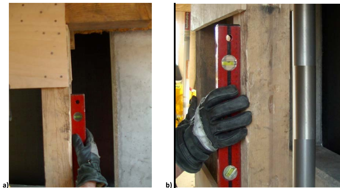
Fot. 32. a) i b) Sprawdzenie prawidłowego ustawienia podpory
