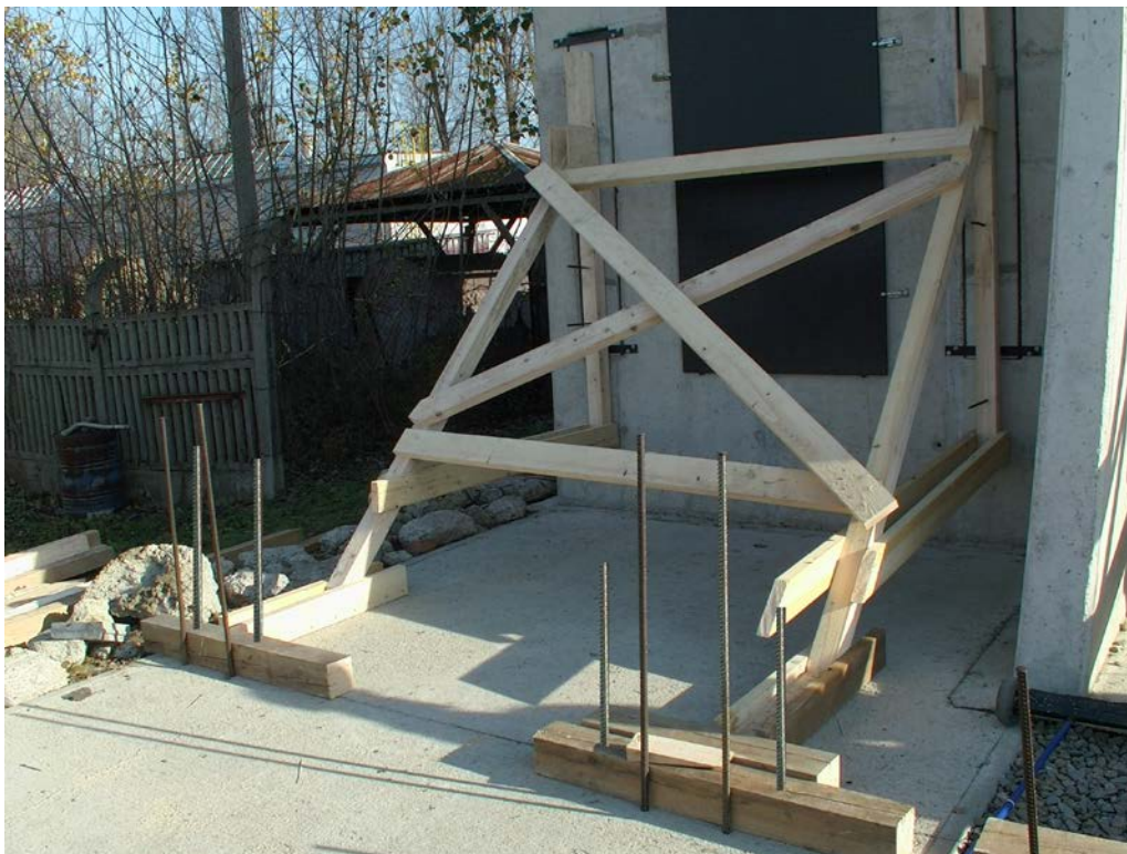
Fot. 86. Podpora ukośna typu – na niepełnym trójkącie
