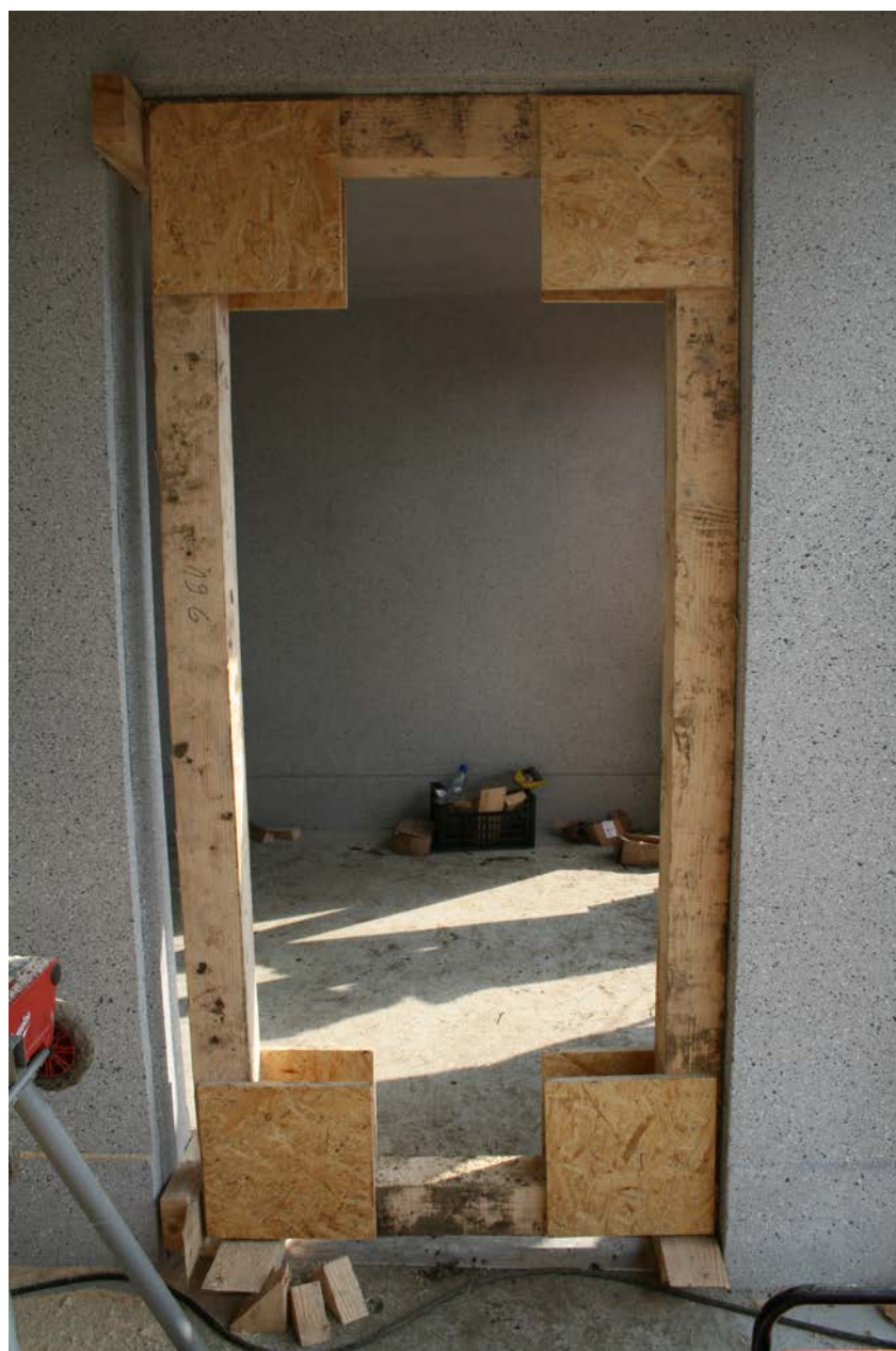
Fot. 58. Przykład podpory zabezpieczającej otwory okienne i drzwiowe typu „prefabrykowana”
