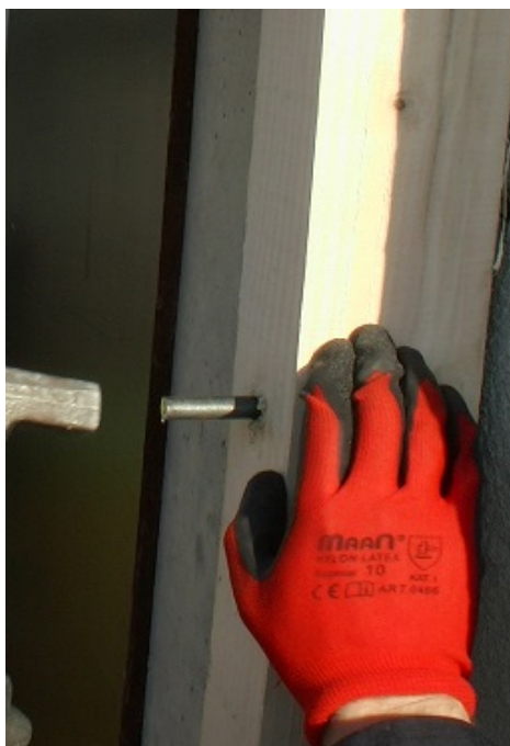
Fot. 77. Kotwienie belki przyściennej do ściany
