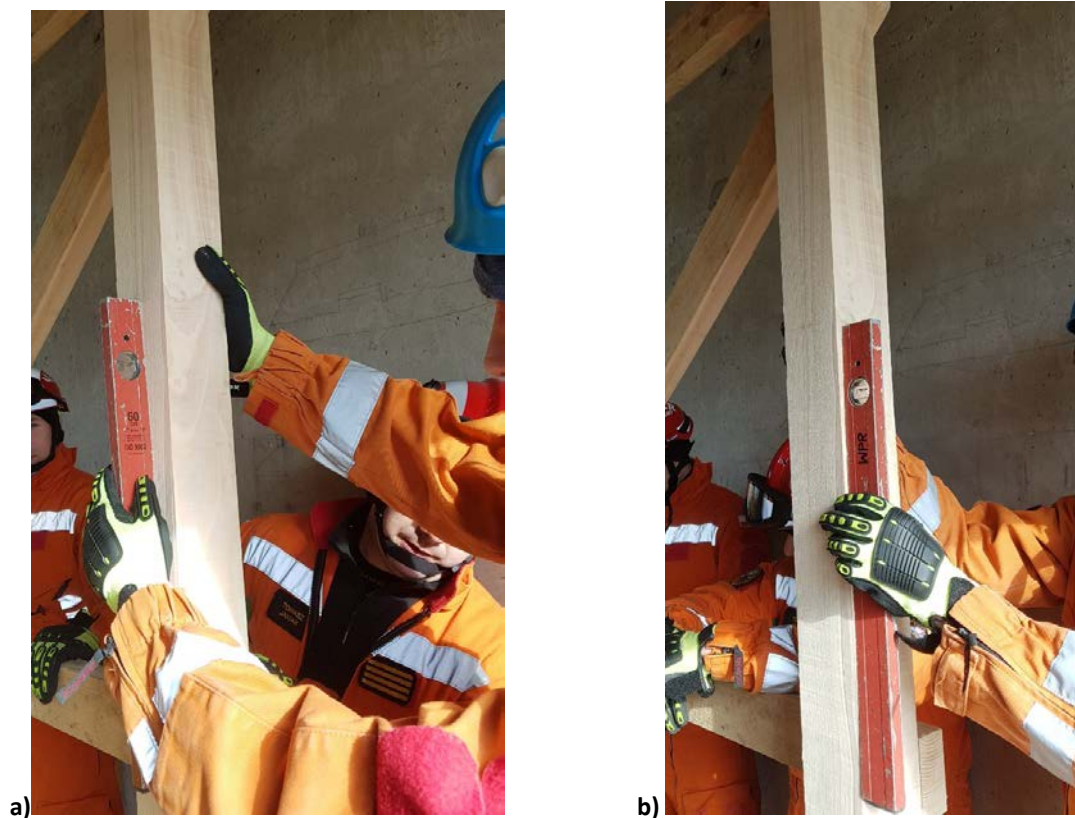
Fot. 43. a) i b) Sprawdzenie prawidłowego ustawienia podpory.
