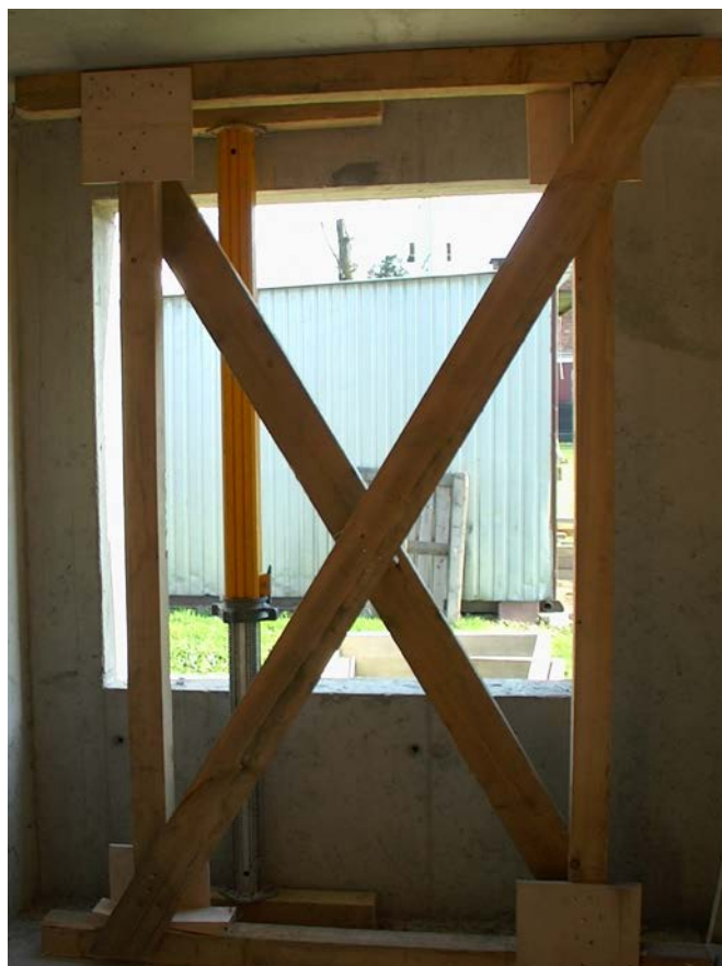
Fot. 39. Podpora pionowa typu „2 lub więcej słupowa”
