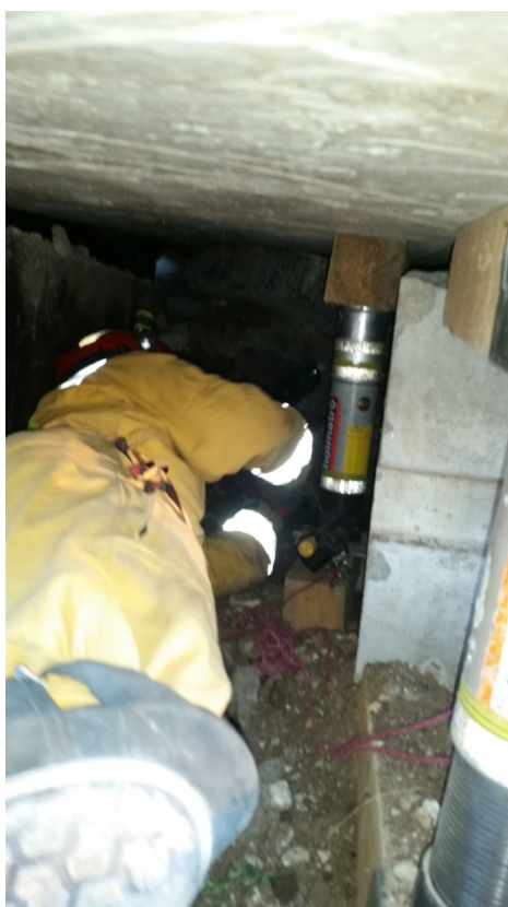
Fot. 11. Podpora mechaniczna wykorzystana do stabilizacji ciasnej przestrzeni
