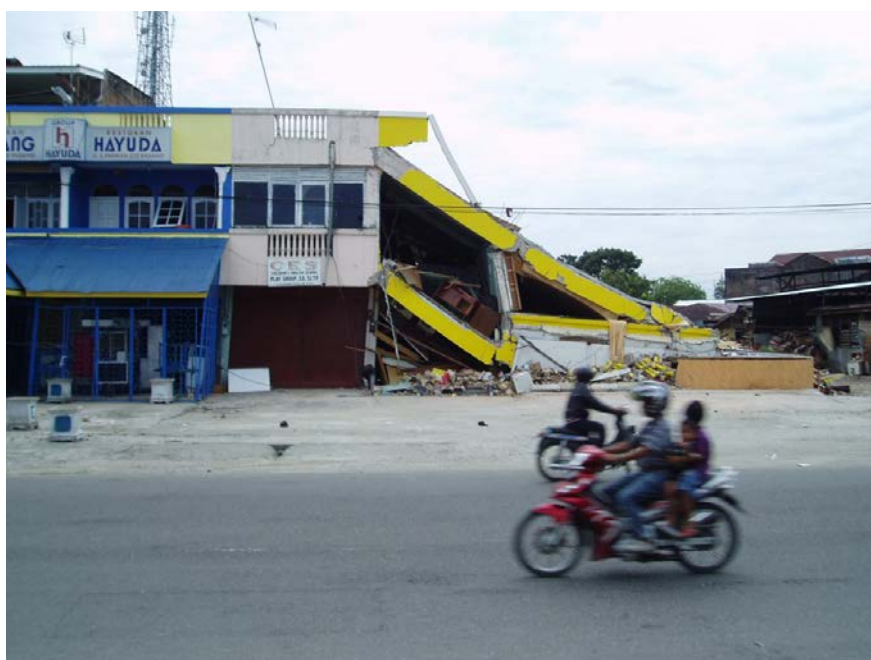
Fot. 4. Zawalenie typu „przybudówka”
