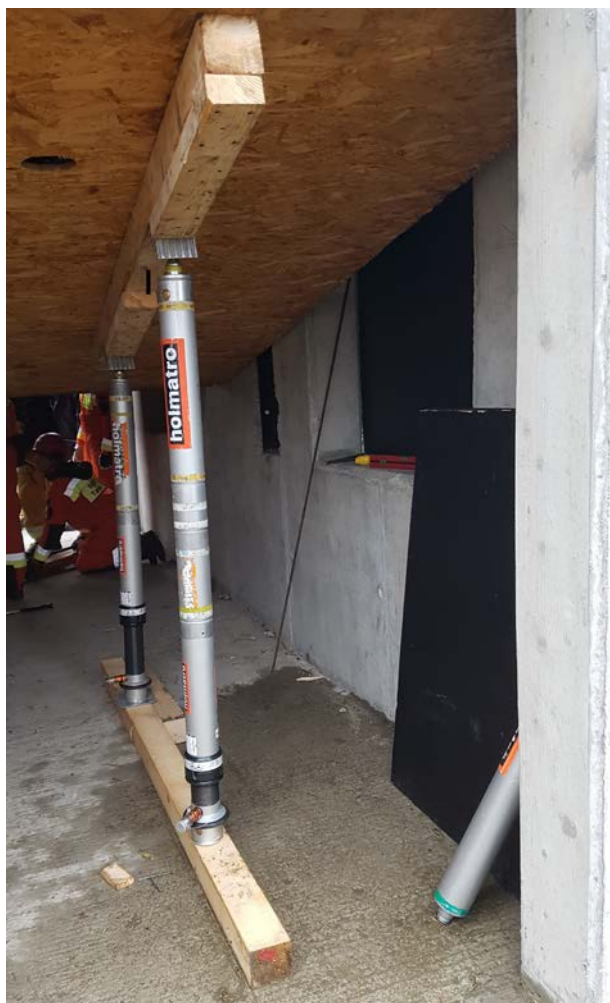
Fot. 67. Ustawiona podpora tymczasowa zabezpieczająca strop pochyły, wiszący
