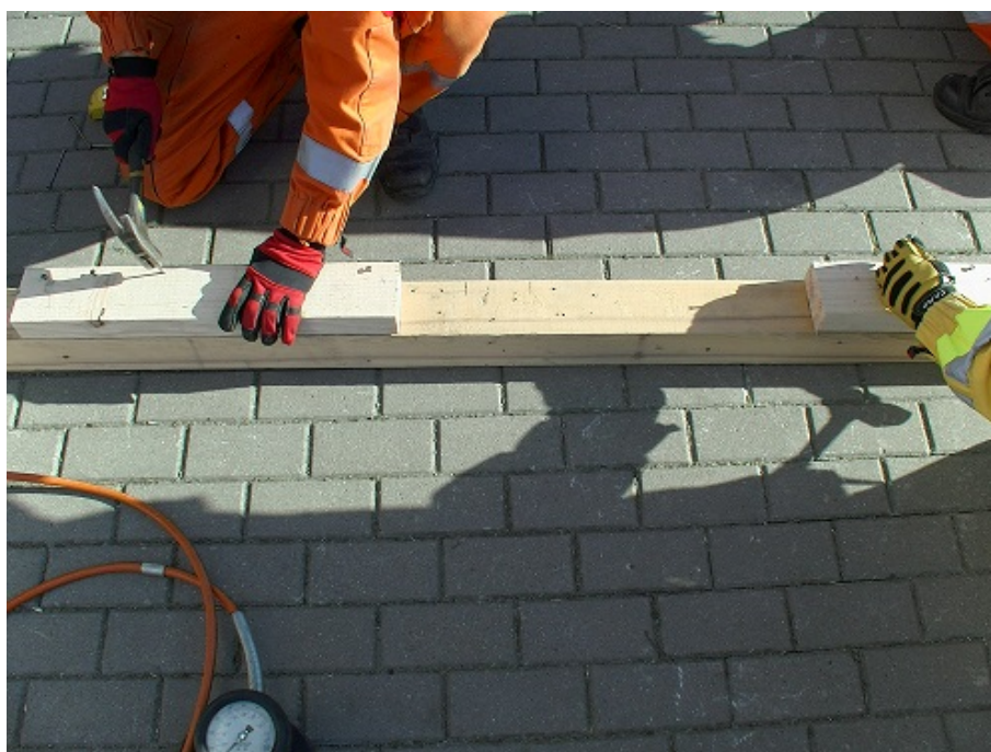
Fot. 60. Połączenie podwaliny z knagami
