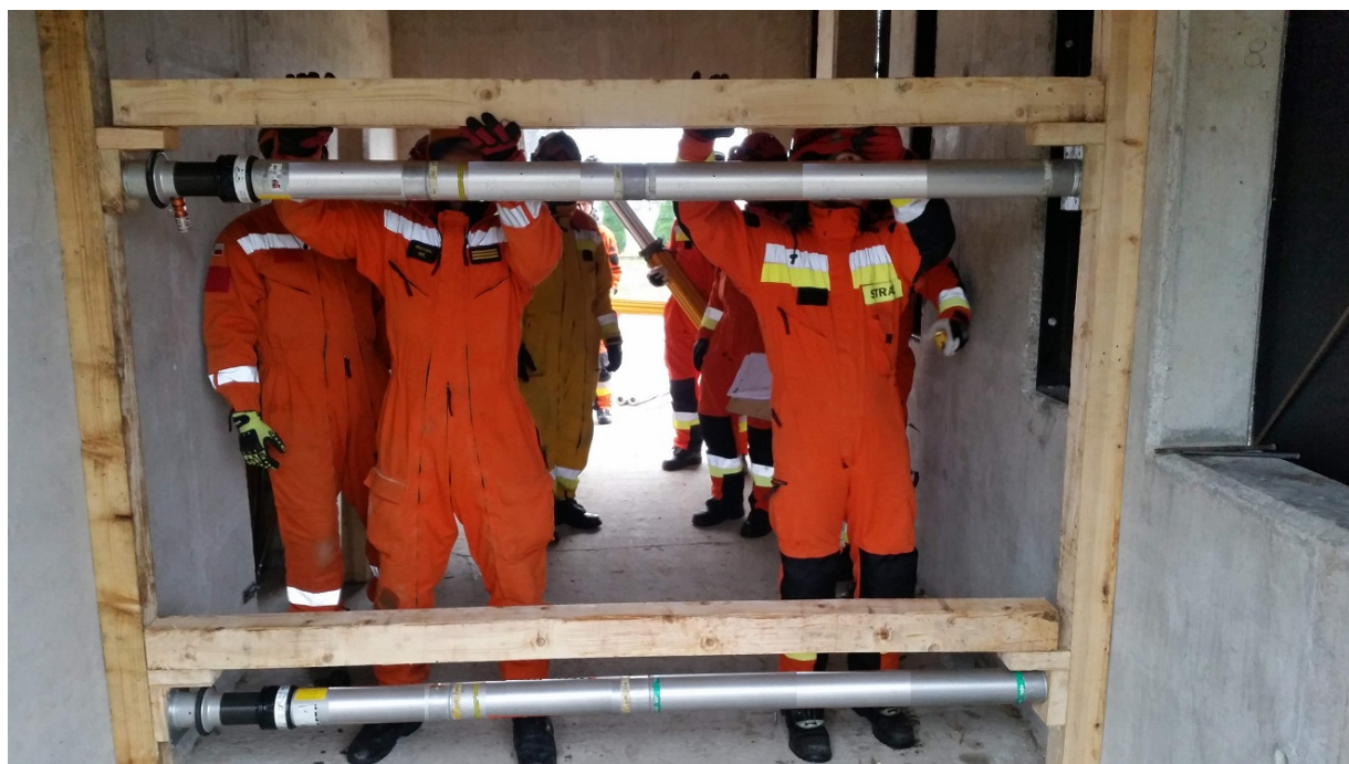
Fot. 73. Umieszczanie rozpory drewnianej na belkach przyściennych
