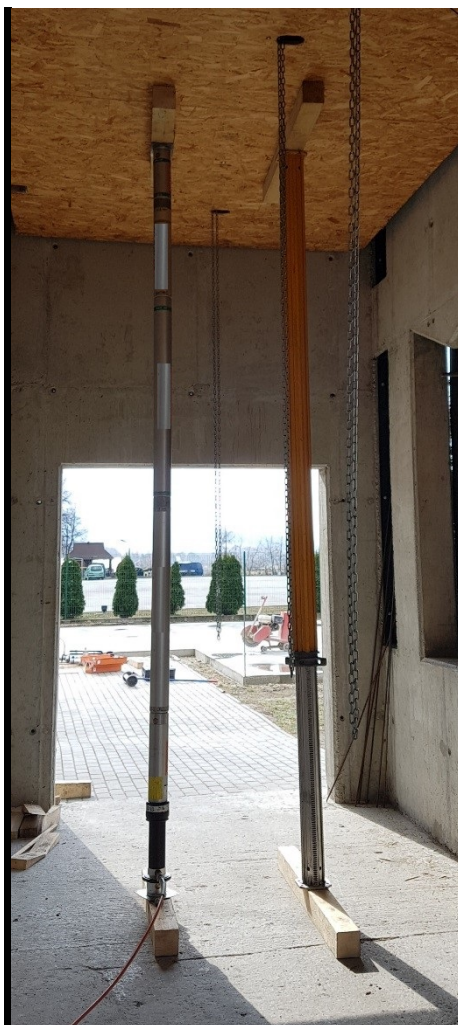
Fot. 41. Montaż pionowych podpór tymczasowych typu „T”
