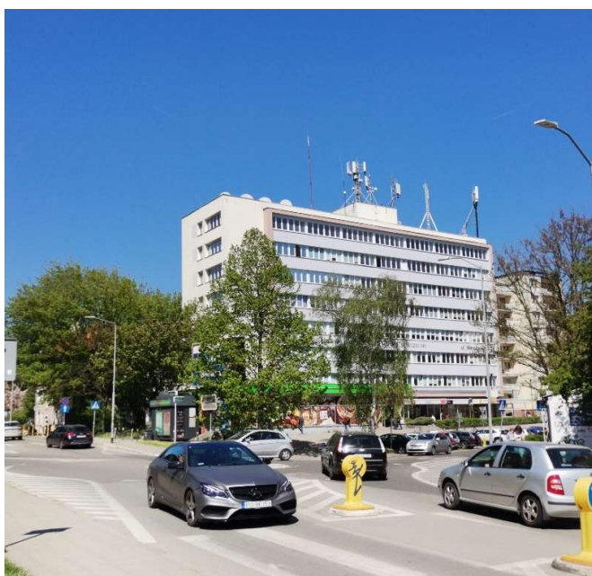
Fotografia 3.1. Stacje bazowe telefonii komórkowej ul. Niemcewicza, Szczecin (źródło: GIOŚ)
