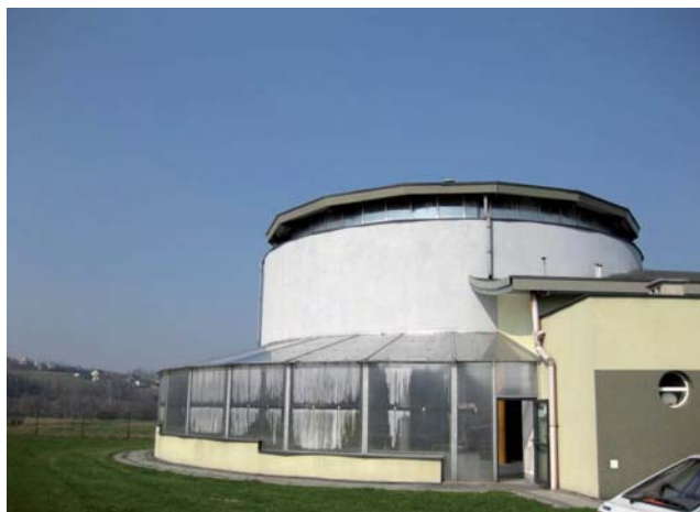
Fot. 1 i 2. Hydroponiczna oczyszczalnia ścieków komunalnych w Łękawicy
