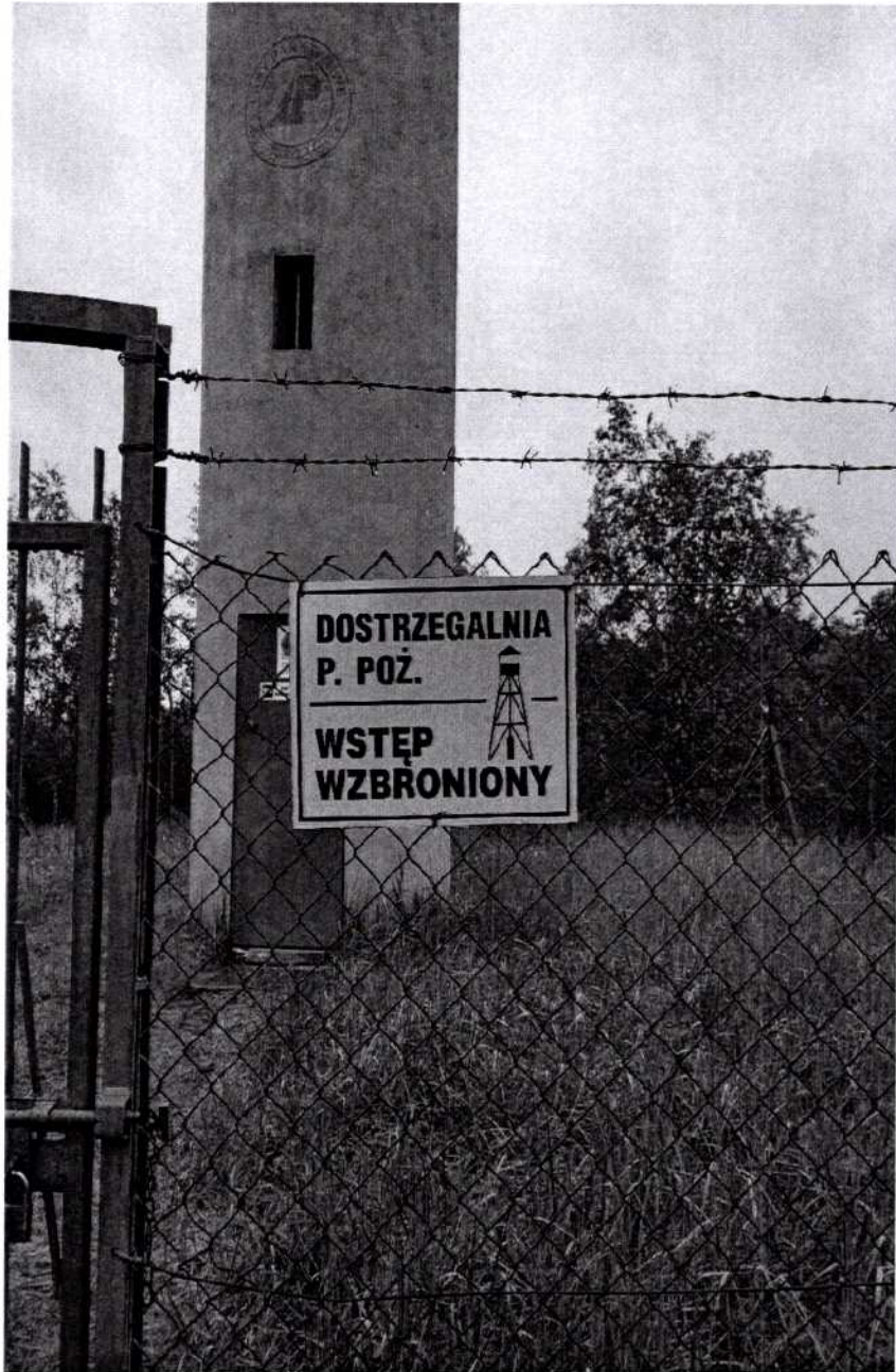
Fot.2 Widok wejście główne do wieży
