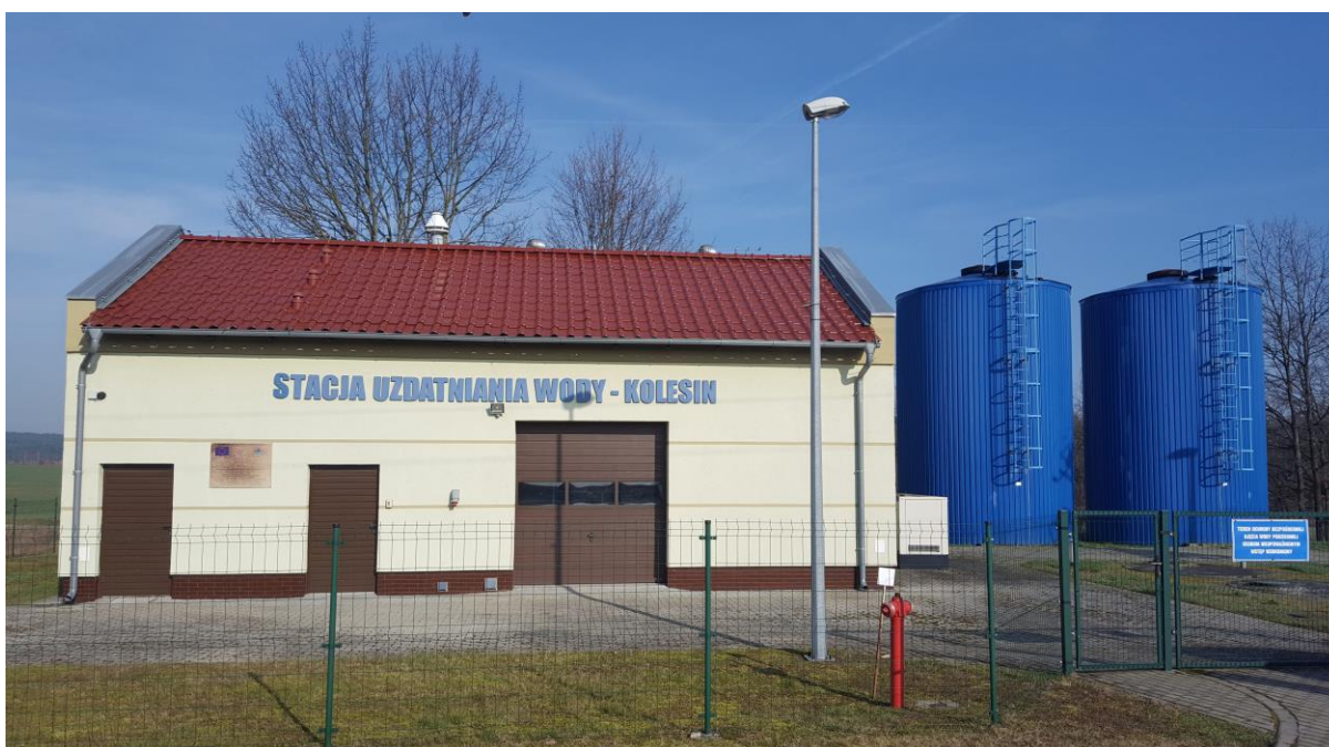
Stacja Uzdatniania Wody w Kolesinie, Źródło: fot. PSSE Zielona Góra
