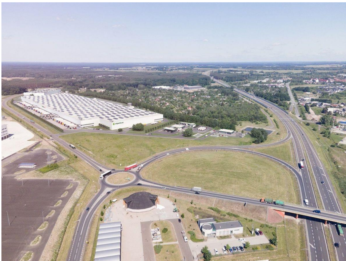
Zródło strona internetowa: https:// eurobuildcee.com Budynki produkcyjno-logistyczne CT Park Sulechów
