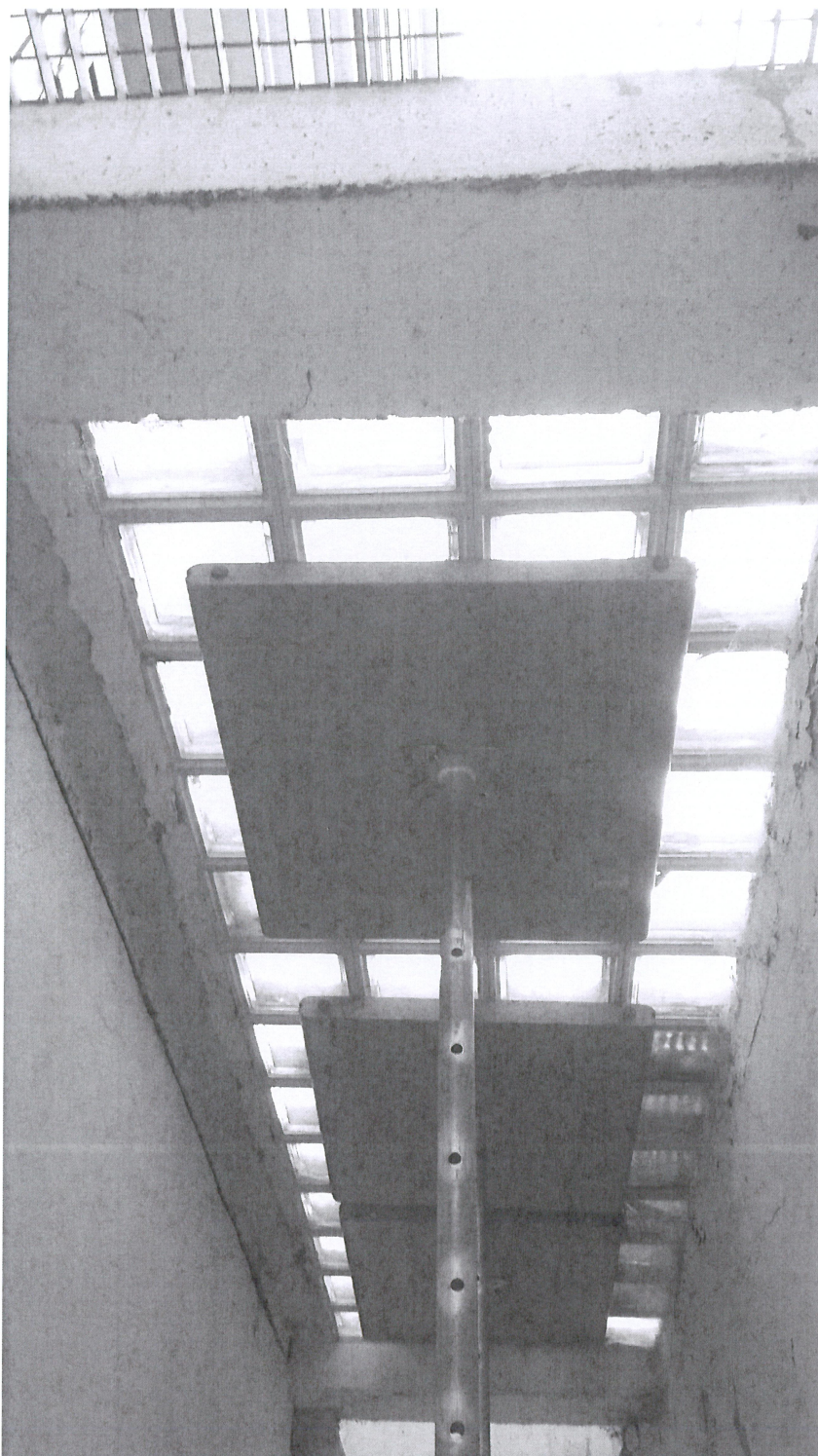
Foto nr 3: Strefa wejściowa – widok od spodu z widocznym podstemplowaniem płyty.
