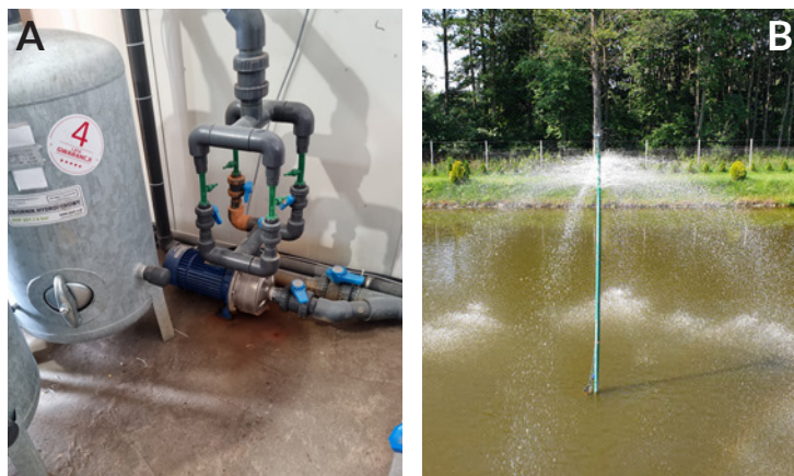
Fot. 34. Przykłady napowietrzanie wody za pomocą inżektorów (A) i zraszania (B). (W. Treder)
