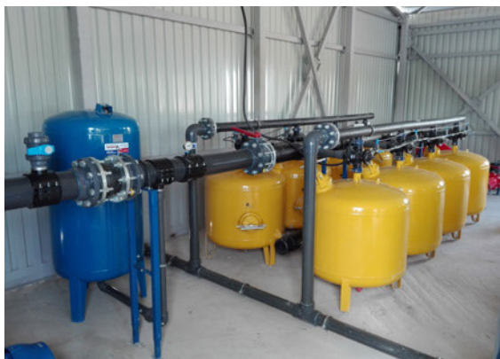
Fot. 32. Zestaw filtrów piaskowych. (W. Treder)
