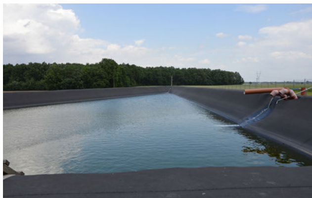
Fot. 14. Zbiornik do gromadzenia wody deszczowej spływającej z dachu szklarni. (W. Treder)
