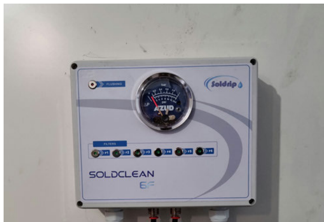
Fot. 33. Sterownik płukania filtrów (Presostat) pracujący w oparciu o pomiar strat ciśnienia na filtrze. (W. Treder)
