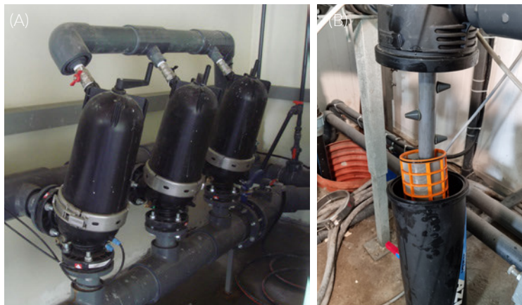
Fot. 28 Zestaw filtrów płukanych półautomatycznie (A) oraz dysze służące do płukania siatki filtracyjnej. (B) (W. Treder)
