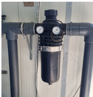
Fot. 26. Filtr wyposażony w manometry. (W. Treder)
