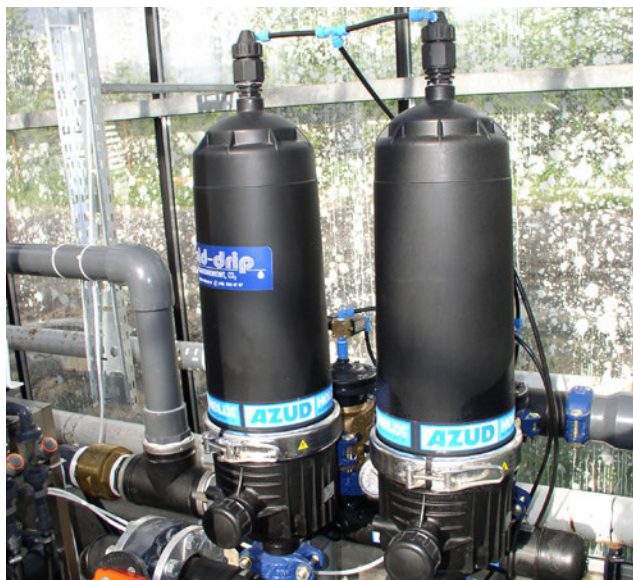
Fot. 31. Zestaw automatycznych filtrów dyskowych. (W. Treder)
