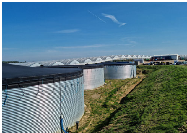
Fot. 16. Buforowe zbiorniki na wodę z blachy falistej zasilające plantację w tunelach. (W. Treder)
