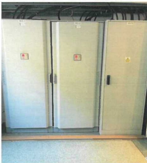
Rysunek 2. Widok elewacji rozdzielnic na parterze budynku
