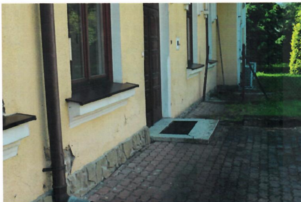
Zarysowania ścian zewnętrznych
