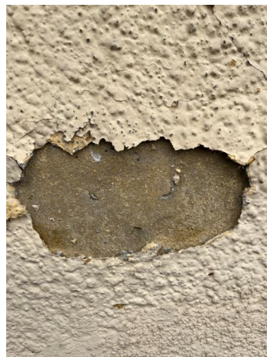
Fot.1, 2. Sondy in situ, widoczne warstwy pierwotnych wypraw
