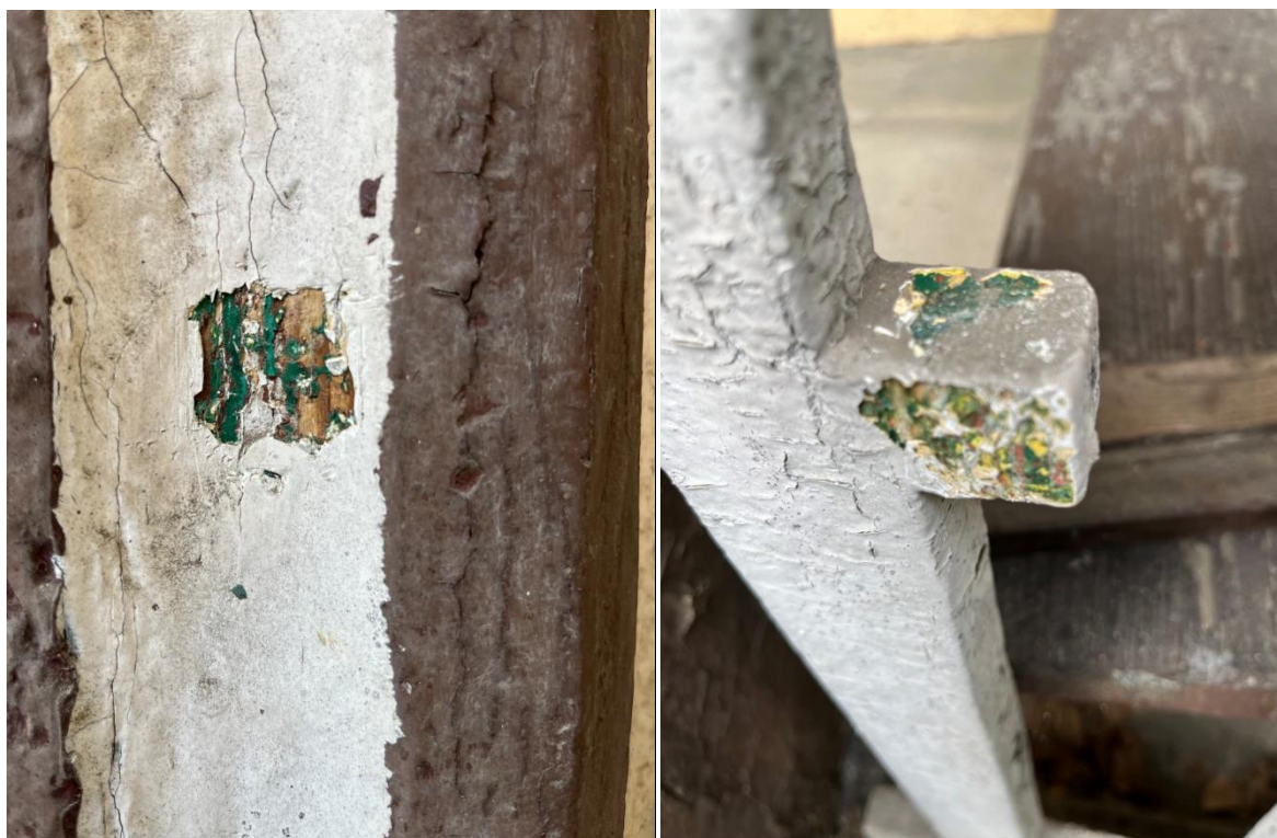
Fot. 9., 10. Fragment drewnianego ganku – sondy „in situ”. Widoczna pierwotna kolorystyka drewna w odcieniach zieleni. Sondy „in situ” na różnych fragmentach dekoracji
