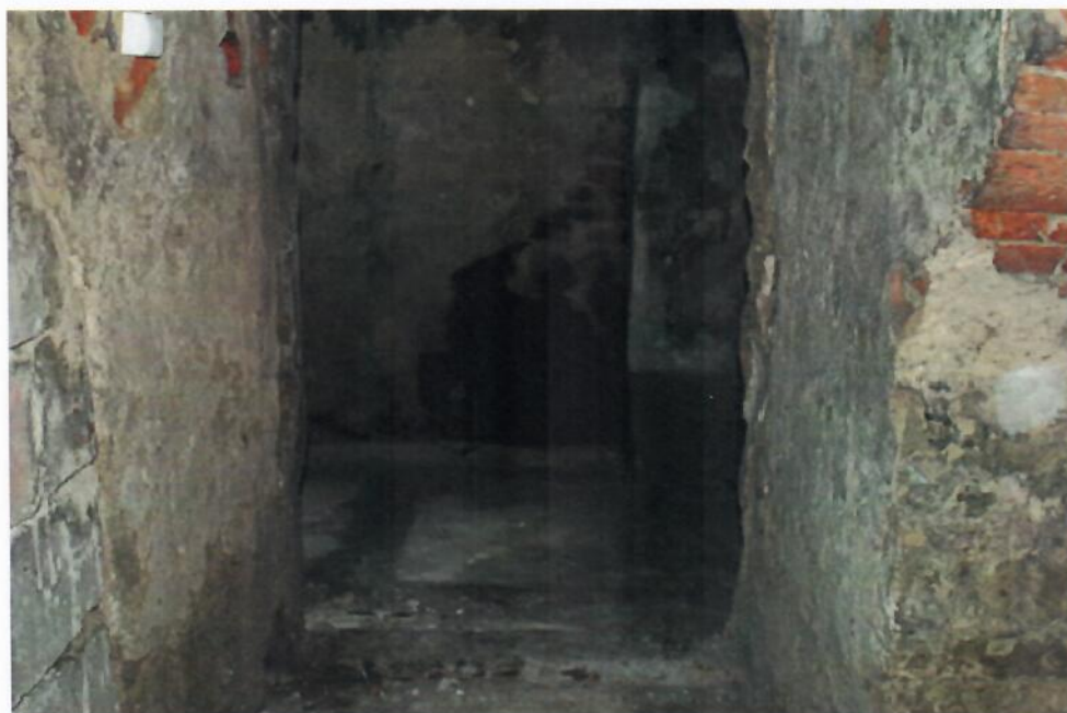
Brak izolacji poziomej i pionowej ściany zawilgocone i zagrzybione
