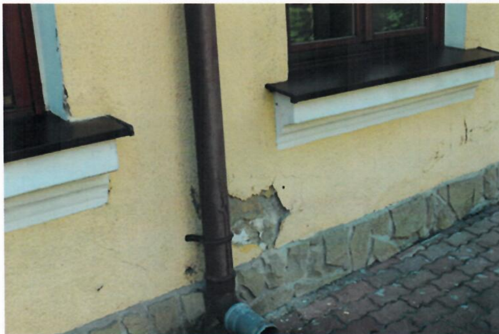
Widoczne wykwity solne i pleśń spowodowane działaniem wilgoci na ściany piwnic
