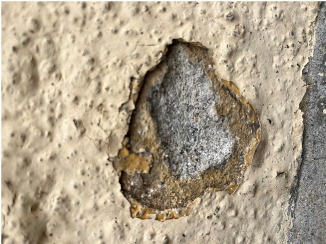
Fot. 5., 6., 7. Widoczna kolorystyka pierwotnych wypraw
