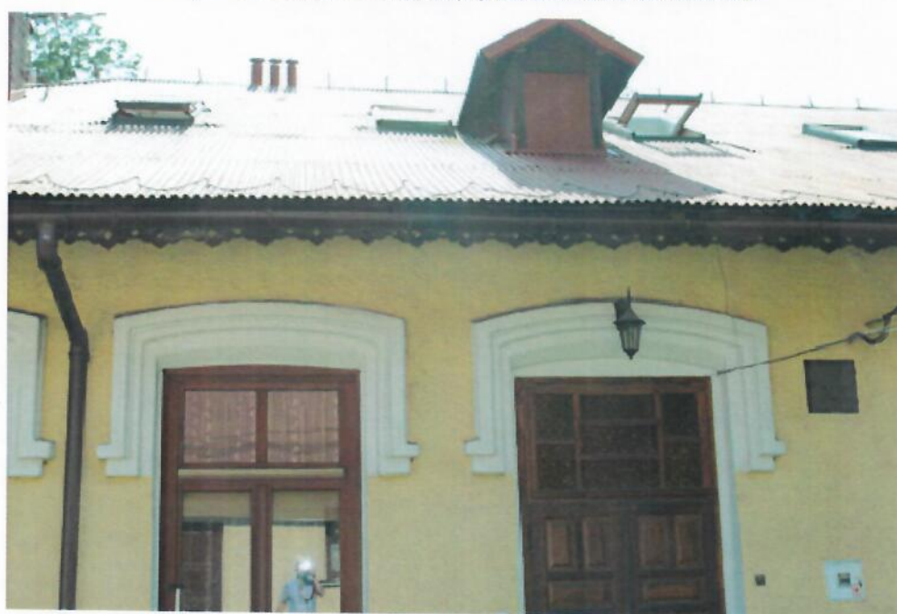
Korozyja elementów pokrycia
