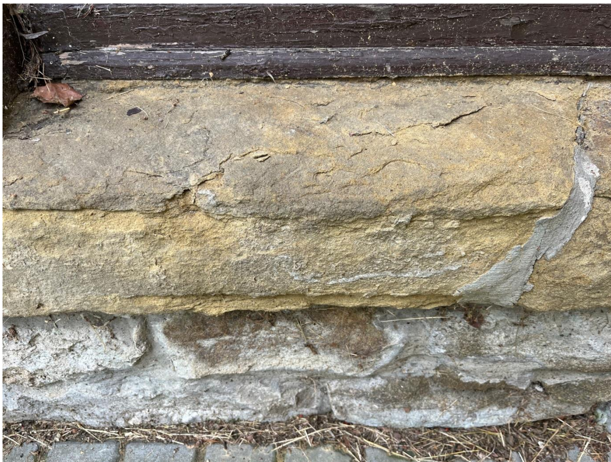
Fot. 7., 8. Stan zachowania. Widoczne przemalowania i zacierki na fragmentach dekoracji.
