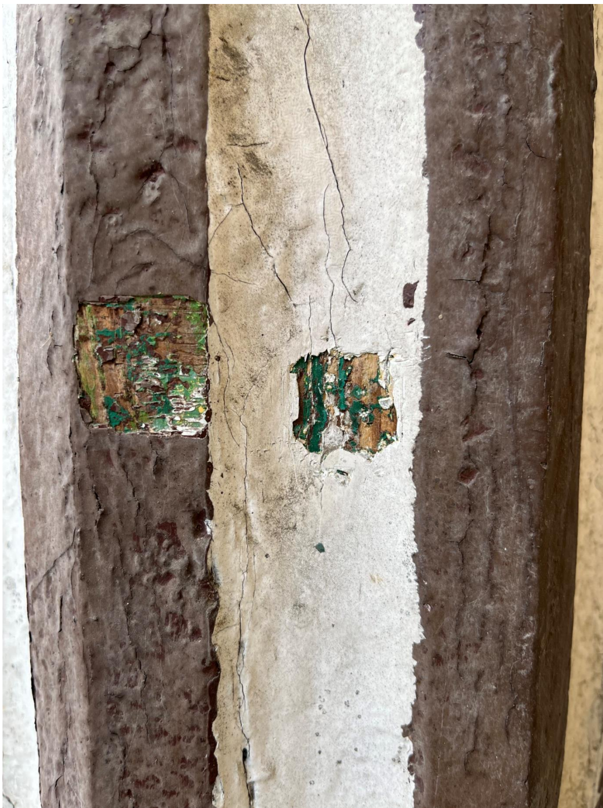
Fot. 8. Fragment drewnianego ganku – sondy „in situ”. Widoczna pierwotna kolorystyka drewna.
