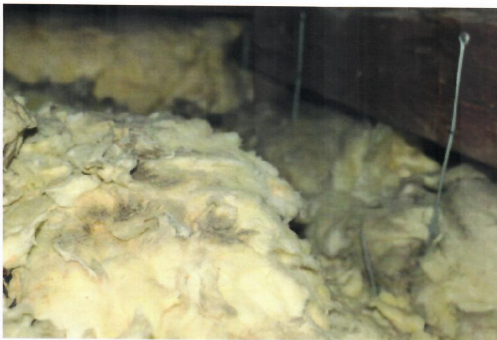
Zniszczone ocieplenie z wełny mineralnej dokonane przez kuny
