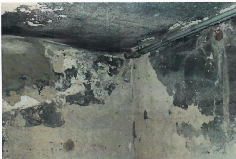
Zawilgocone sklepienie piwnic
