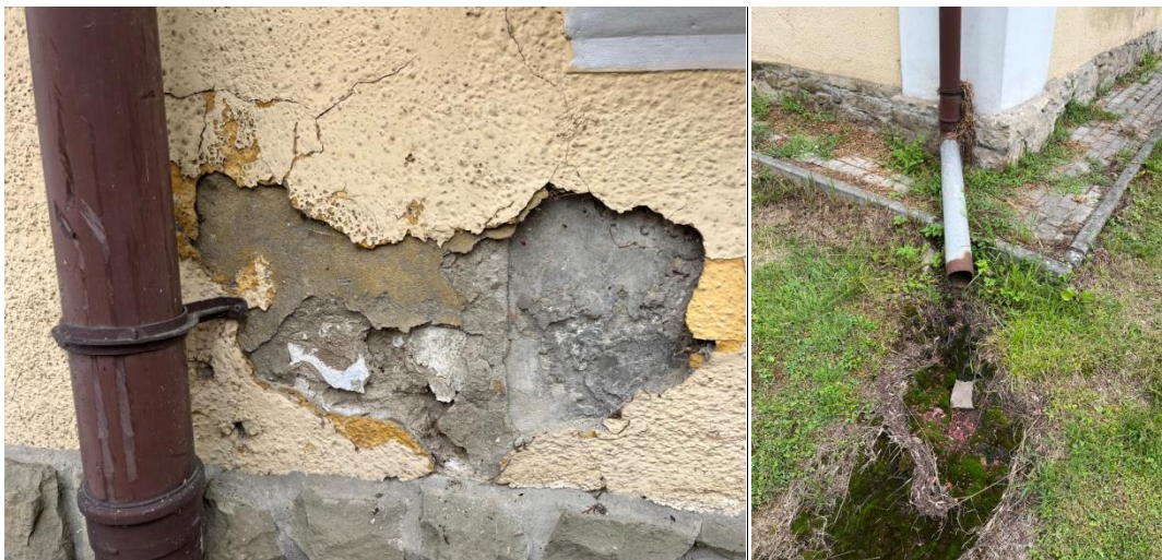
Fot. 3., 4. Stan zachowania. Widoczne zniszczenia spowodowane stałym zawilgoceniem partii elewacji
