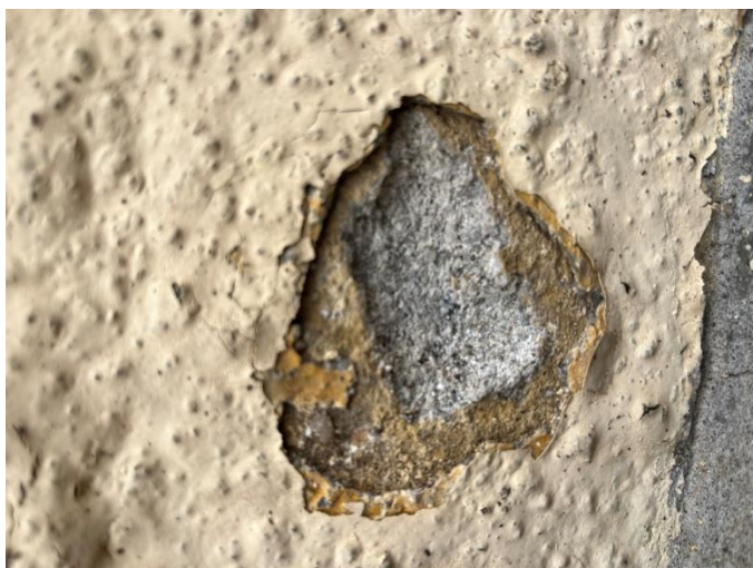
Fot.1, 2. Sondy in situ, widoczne warstwy pierwotnych wypraw
