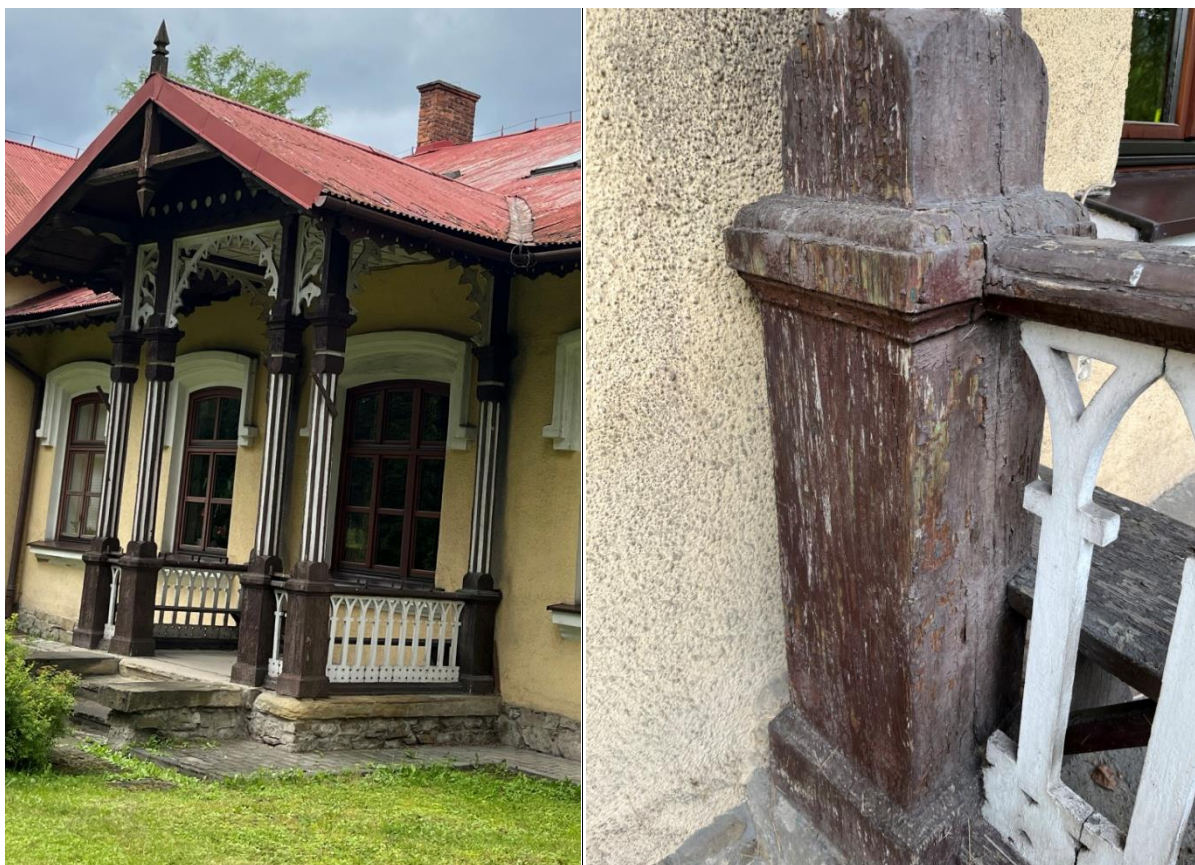
Fot. 10., 11. Stan zachowania elementów drewnianych ganku.
