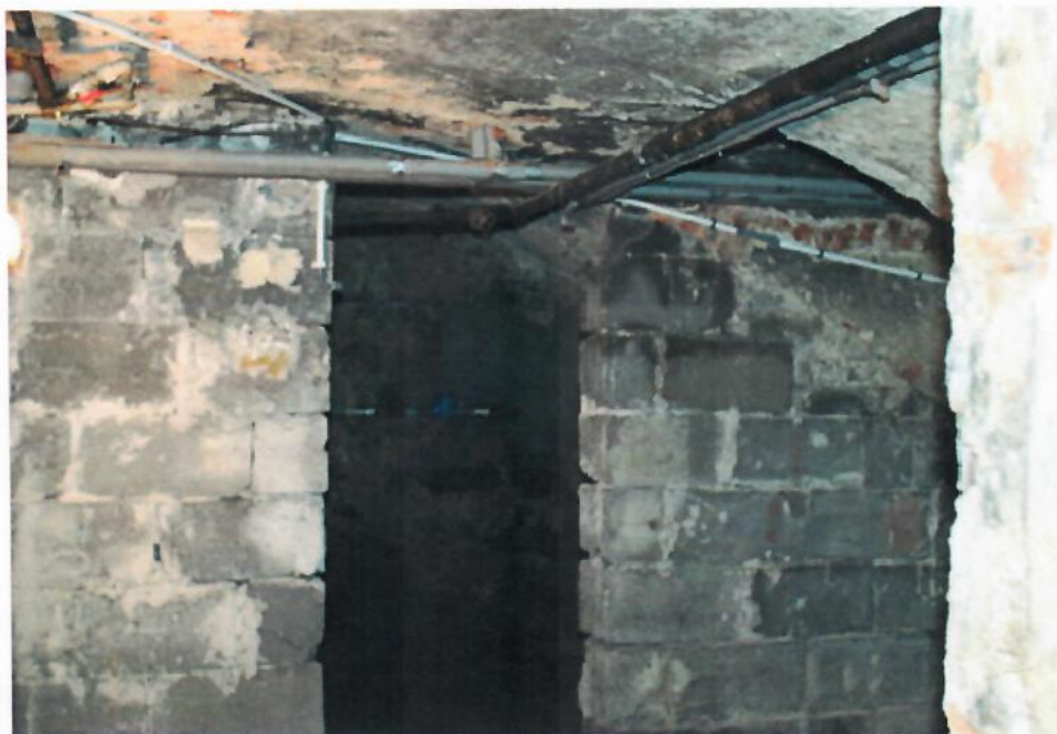
Wilgoć przechodząca na poziom parteru
