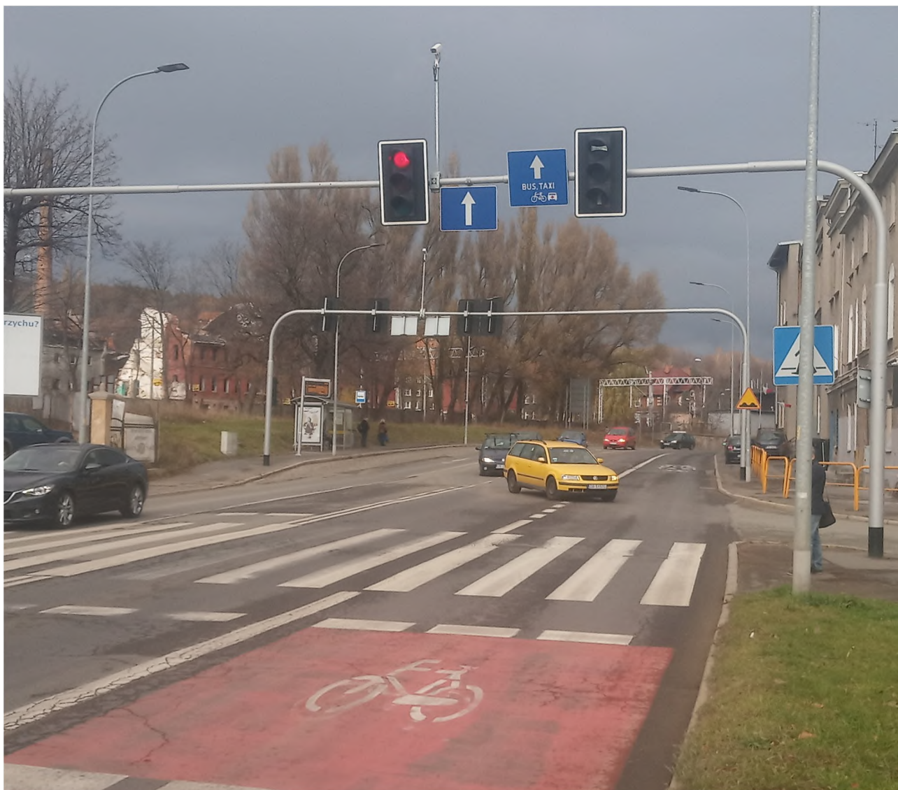
Zdjęcie 1: Zbędny sygnalizator SB (Wałbrzych, ul. Armii Krajowej / DK35)
