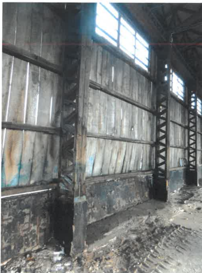
5. Słupy oraz ściany prefabrykowane.
