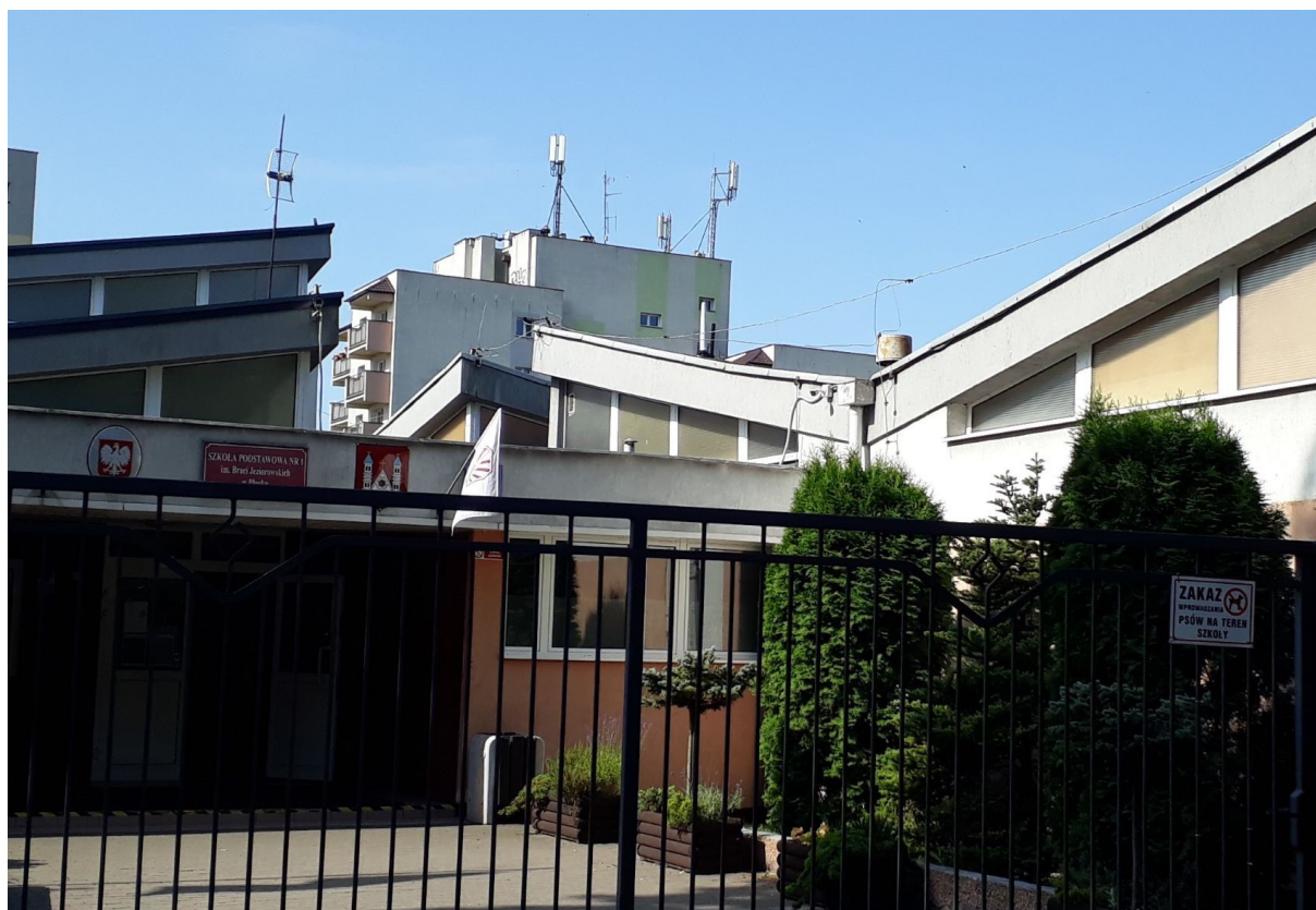
Rys. 2 Miejsce montażu SMS PEM – Szkoła Podstawowa nr 1 w Płocku – widok z poziomu gruntu
