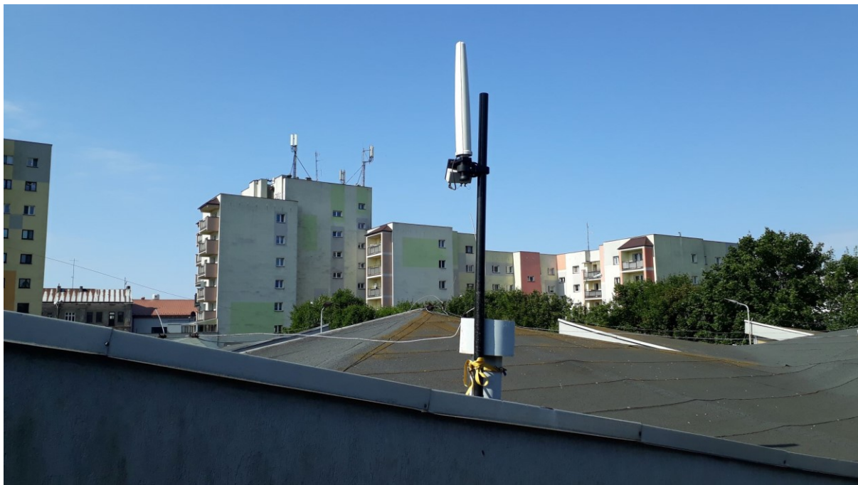
Rys. 3 Miejsce montażu SMS PEM – Szkoła Podstawowa nr 1 w Płocku – widok na SBTK
