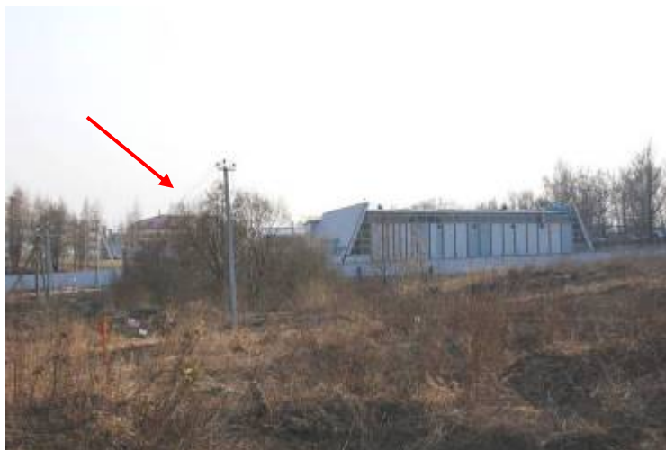
Rys. 9. Zerwane przewody linii energetycznej (pkt 7 rys. 2)
