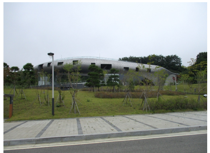
Rys. 9. Wejście do składowiska odpadów promieniotwórczych w Gyeongju (fotografia własna).
