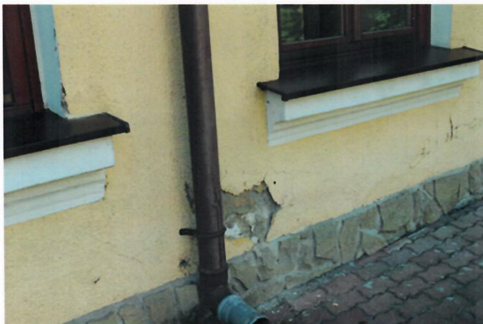
Widoczne wykwyty solne i pleśń spowodowane działaniem wilgoci na ściany piwnic
