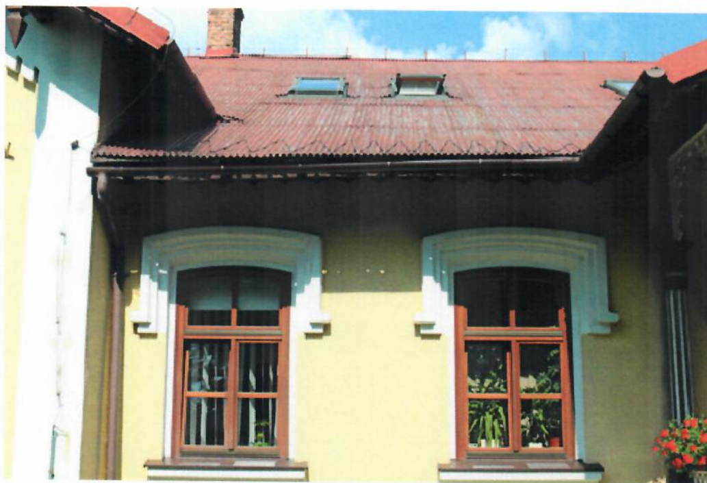
Korozja elementów pokrycia blaszanego, braki zabezpieczeń antykorozyjnych
