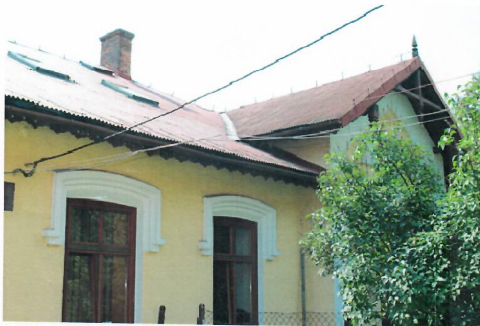
Zniszczone pokrycie dachu
