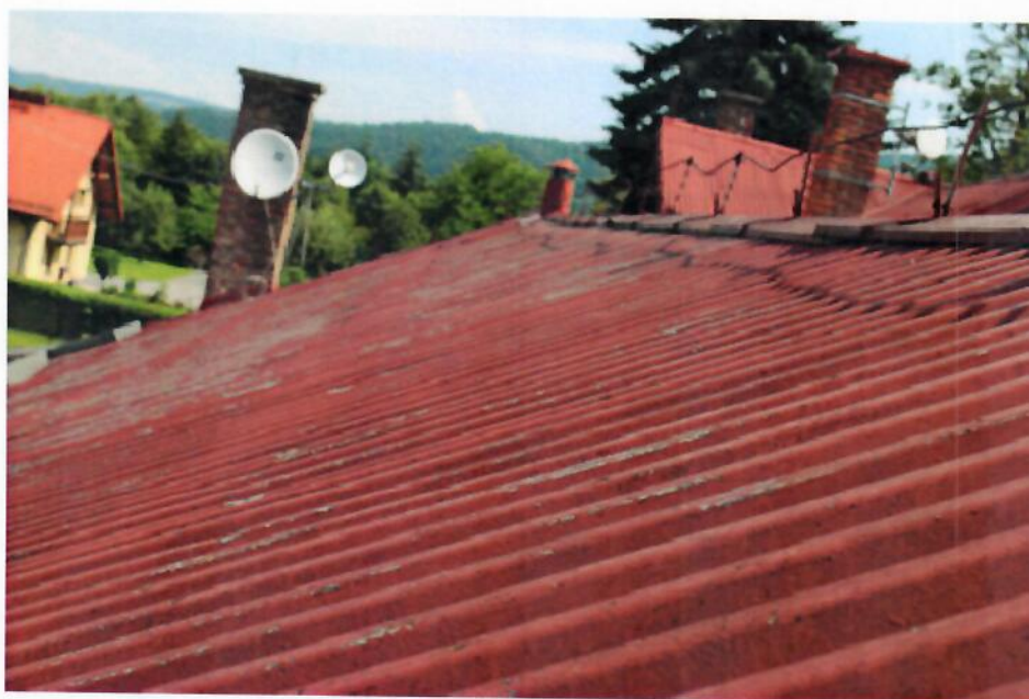
Korozja blachy i ubytki zabezpieczeń antykorozyjnych
