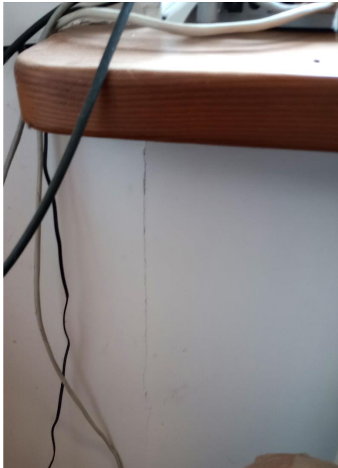
Fot. 8 Pomieszczenia kancelarii Krajewo – pomieszczenie biurowe
