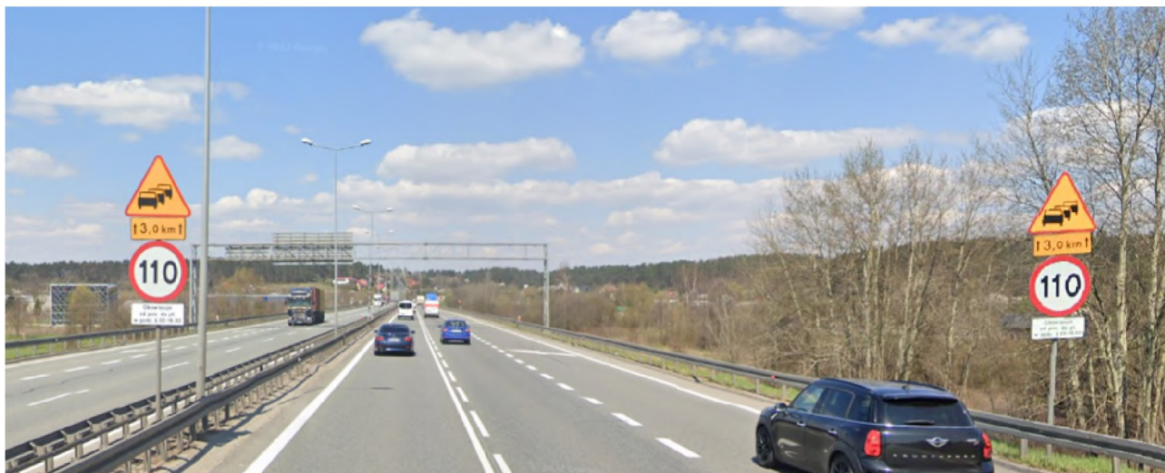
Zdjęcie 1: Znak B-33 z nieczytelną tabliczką. Autostrada A4 (obwodnica Krakowa). Fot: Google Street View
