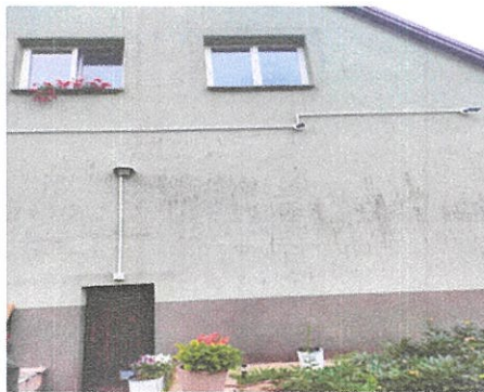
Wejście z zewnątrz do piwnicy
