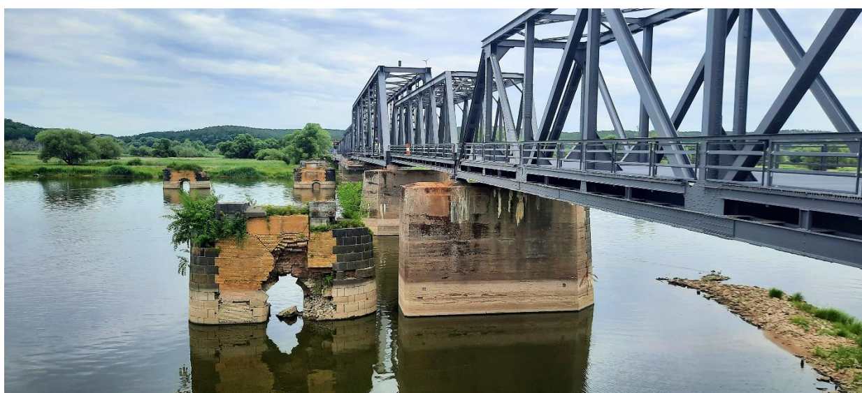
Rysunek 74. Wyremontowany most w Siekierkach: nowy obiekt na fundamentach pierwotnej budowli (Fot. J. Czekirda)
