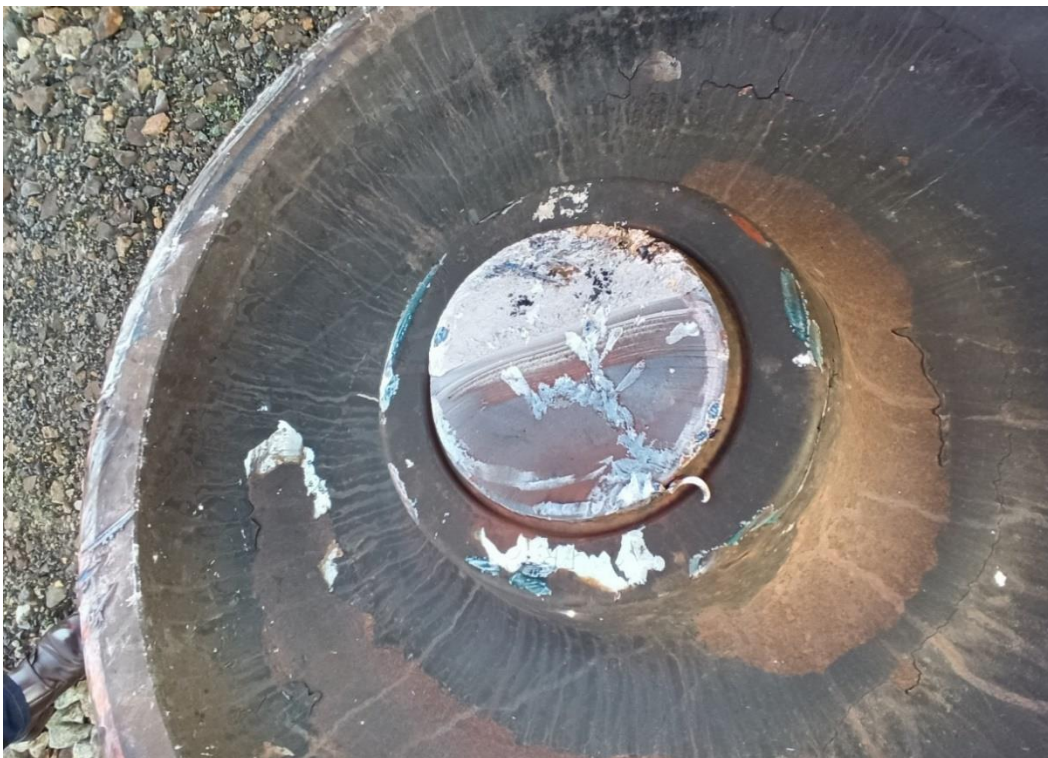
Zdjęcie 6 - Widok złamanej osi ( materiał przekazany przez komisję kolejową)
