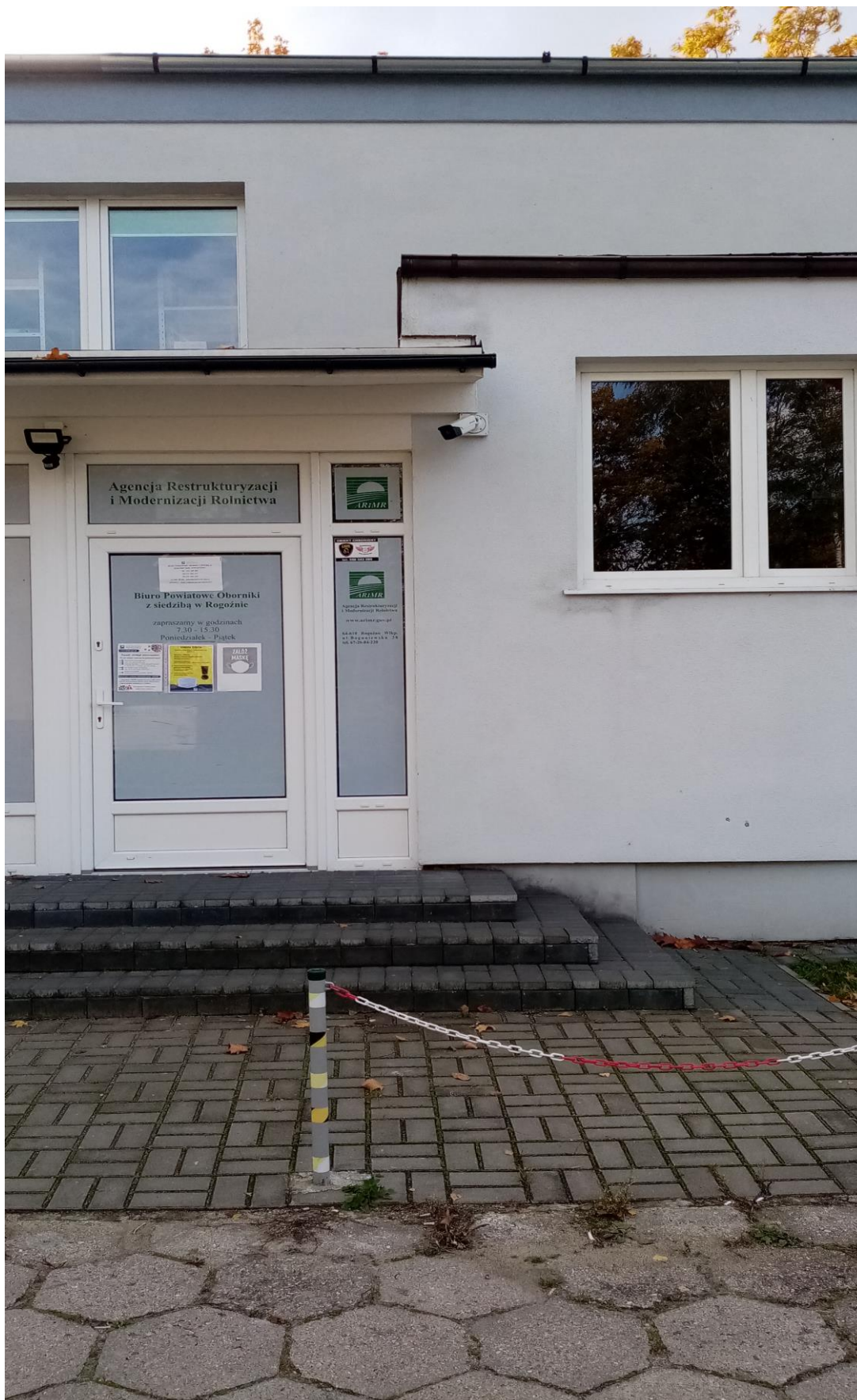
Wejście do budynku jest po schodach, nie znajduje się na poziomie chodnika.
