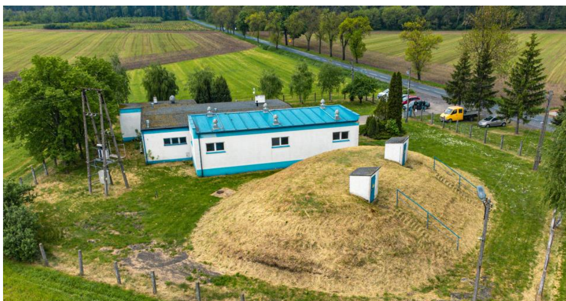
Zdjęcie 3. Stacja Uzdatniania Wody Drzewce
