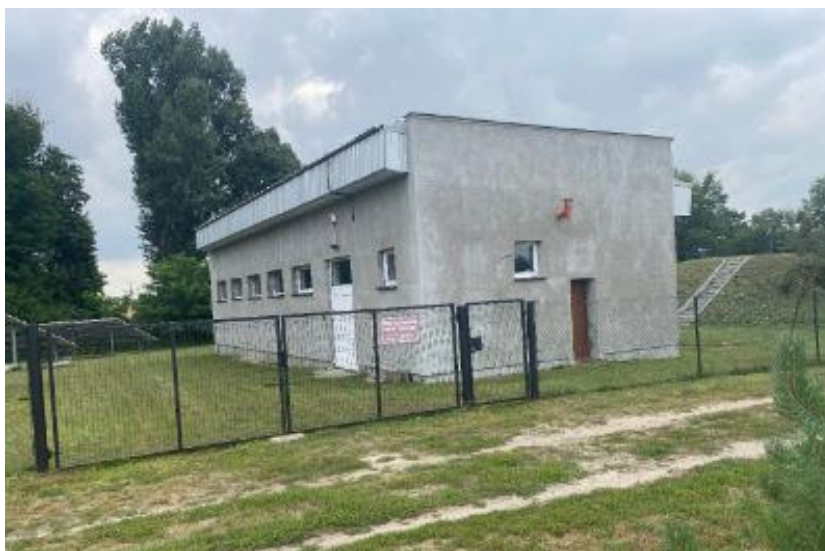
Zdjęcie 2. Stacja Uzdatniania Wody w Jeżewie
