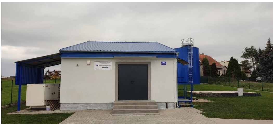
Zdjęcie 1. Stacja Uzdatniania Wody Brzezcie
