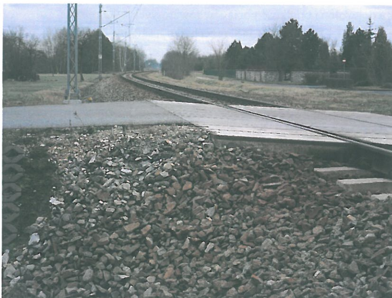
Fot. 19, 19a. Widok przejazdu po rewitalizacji
