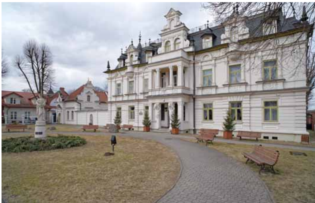
Widok pałacu od strony dziedzińca
