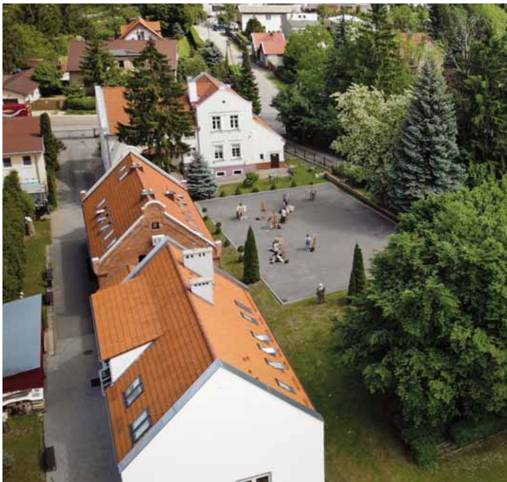
Zespół budynków Liceum Plastycznego w Gronowie Górnym
