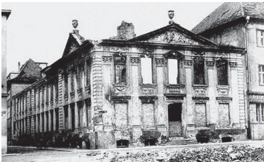
Aktualna siedziba Zespołu Państwowych Szkół Muzycznych im. Feliksa Nowowiejskiego w Szczecinie — stan zniszczeń wojennych po 1945 roku
