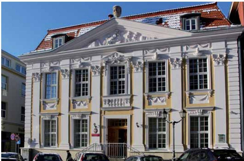
Siedziba szkoły — stan obecny
