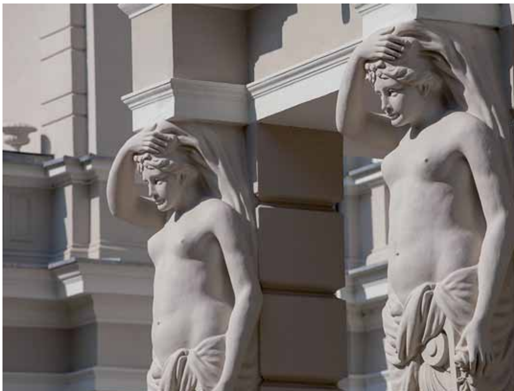
Odnowione detale portyku wejściowego
