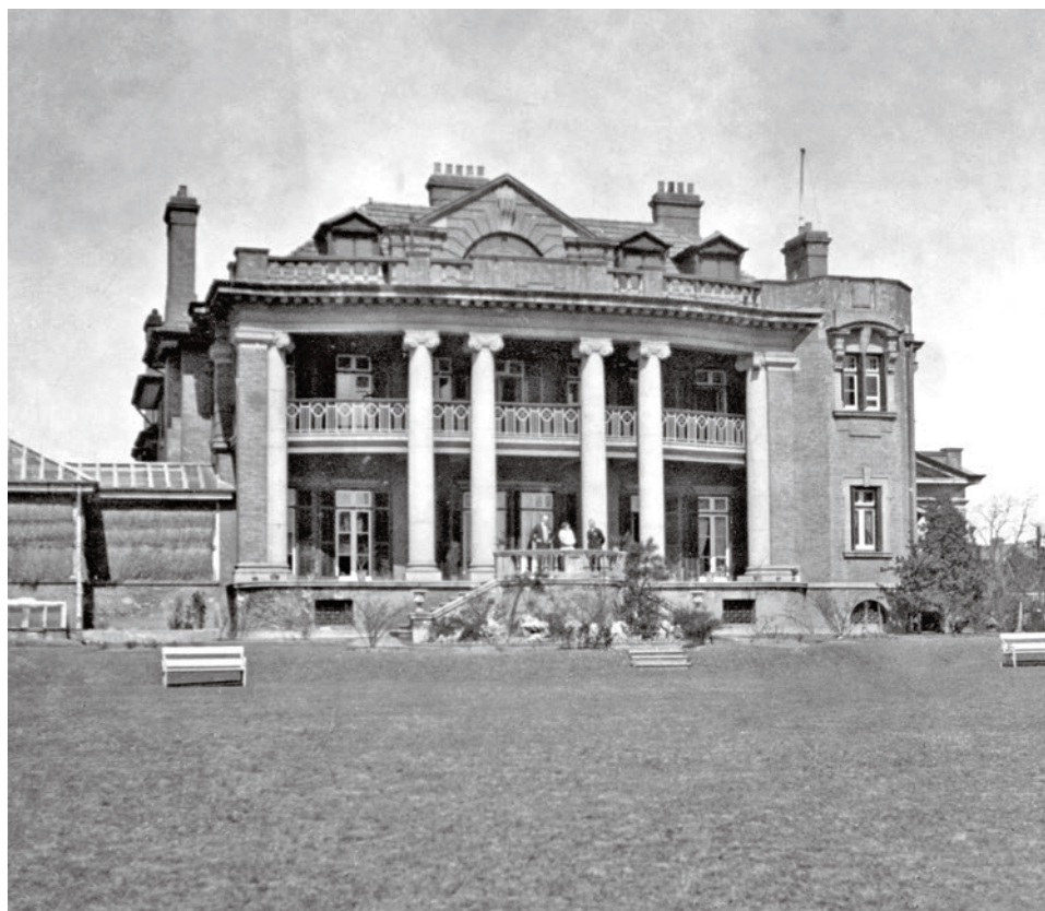
Edificio de la Legación de la República de Polonia en Shanghái en 1932
