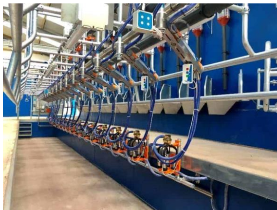
Fot. 7. Hala udojowa typu swing over (Źródło: https://www.boumaticgascoignemelotte.ie/swing-over/ )
