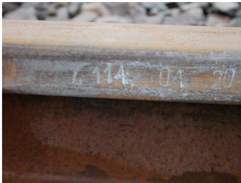
Zdjęcie 5 – Numer identyfikujący operatora zgrzewarki
