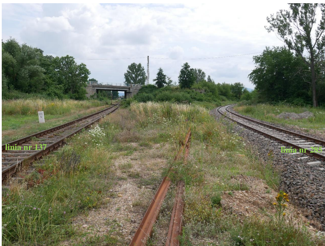
Zdjęcie 7 – Widok na miejsce najechania na linii nr 285 (po prawej) w sąsiedztwie czynnej linii nr 137 (z lewej strony)
