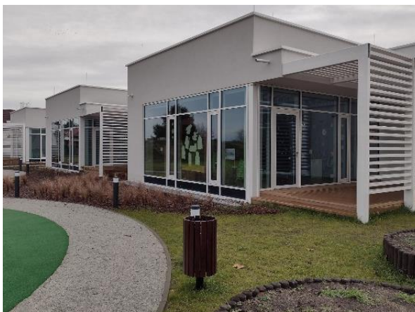
Rys. 4. Budynek Przedszkola Nr 4 w Wągrowcu
