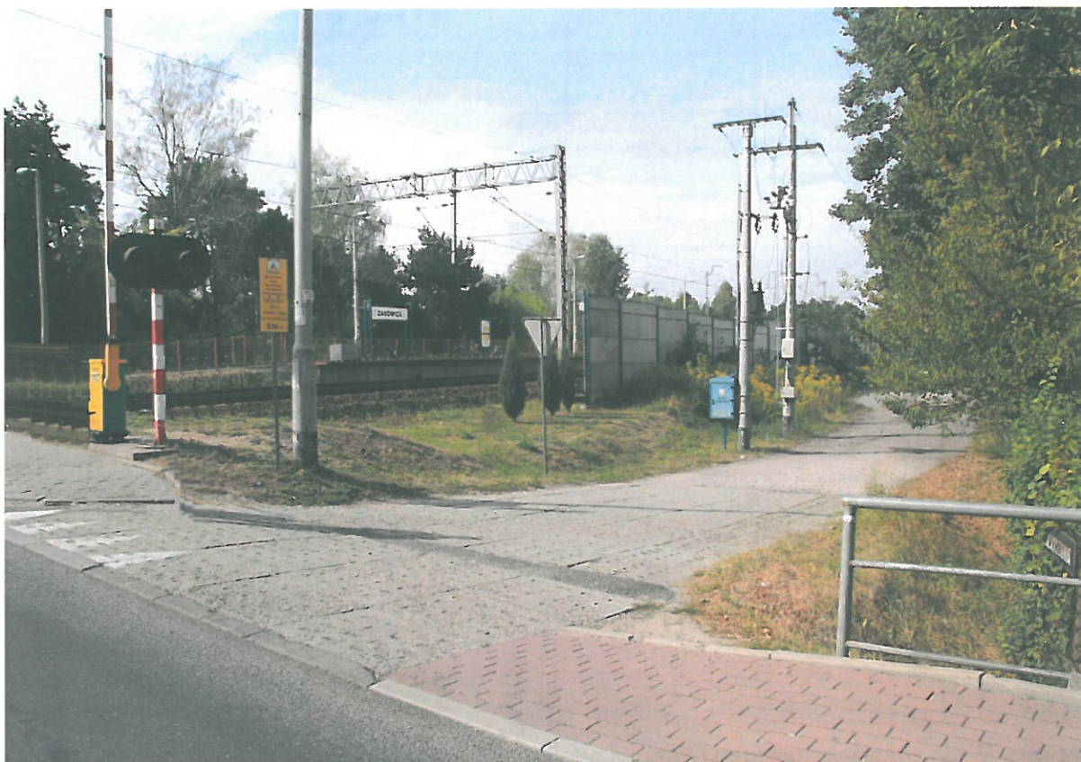
Fot. 10. Widoczność torów w kierunku Gałkówka z linii zatrzymania pojazdów drogowych, strona toru nr 2. (fot. wł. PKBWK)
