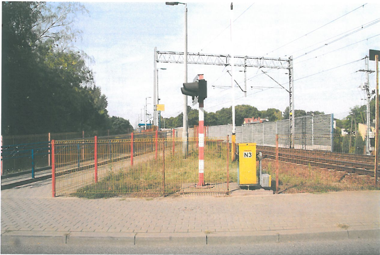
Fot. 8. Widoczność w kierunku Gałkówka z 5 m od szyny skrajnej, strona toru nr 1. (fot. wł. PKBWK)
