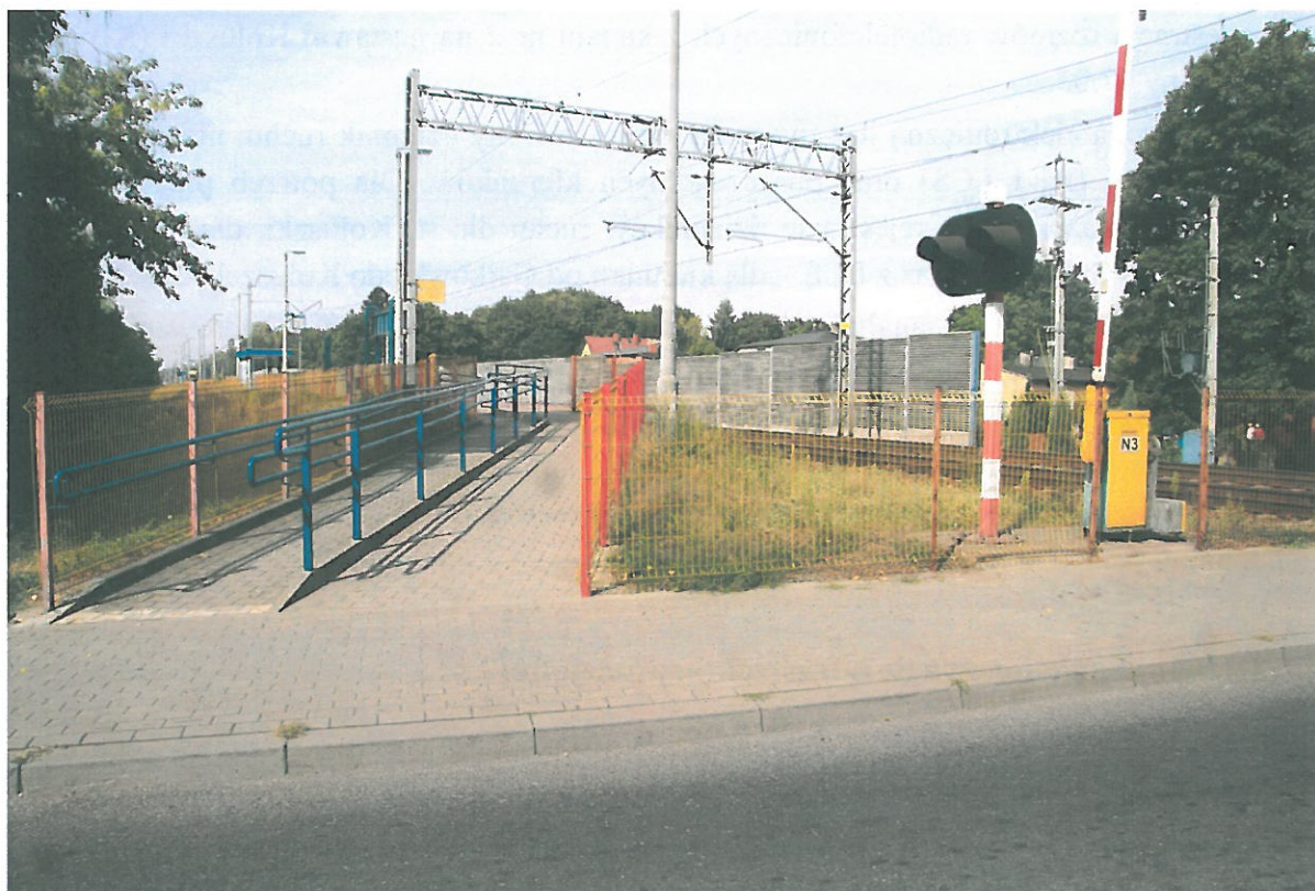
Fot. 7. Widoczność torów w kierunku Gałkówka z linii zatrzymania pojazdów drogowych, strona toru nr 1. (fot. wł. PKBWK)
