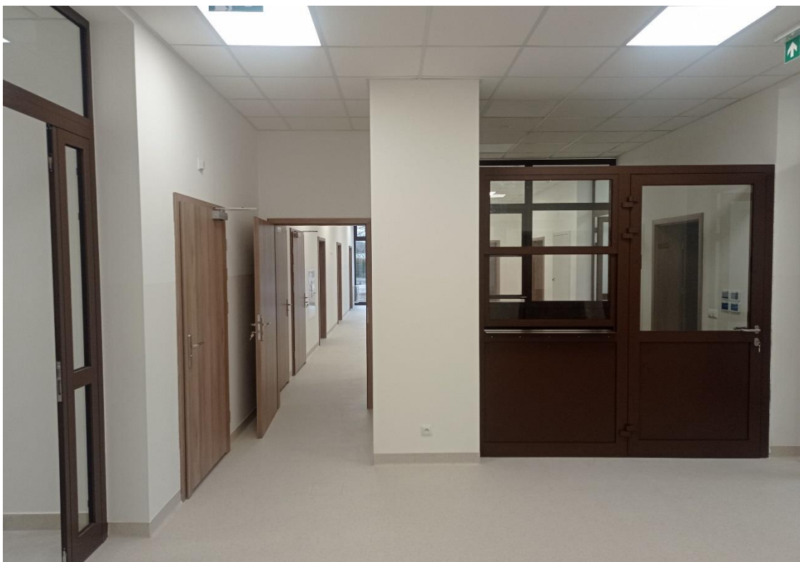
Fot. 11 wnętrze budynku Samorządowego Zakładu Opieki Zdrowotnej w Wąchocku wraz z garażem, niezbędną infrastrukturą towarzyszącą przy ul. Błonie,
