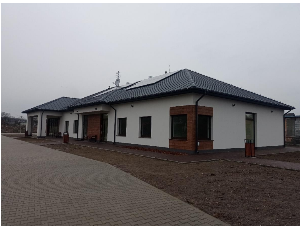
Fot. 10 budynek Samorządowego Zakładu Opieki Zdrowotnej w Wąchocku wraz z garażem, niezbędną infrastrukturą towarzyszącą przy ul. Błonie.
