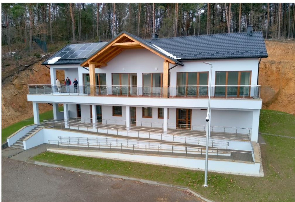
Fot. 8 budynek administracyjny z węzłem sanitarnym przy ul. Panoramicznej w miejscowości Ruda w ramach zadania „Zagospodarowanie terenu Rozwoju potencjału endogenicznego, poprzez wykorzystanie walorów turystycznych Zalewu Brodzkiego usytuowanego w Dolinie Kamiennej w Stykowie i Rudzie”, gm. Brody,
