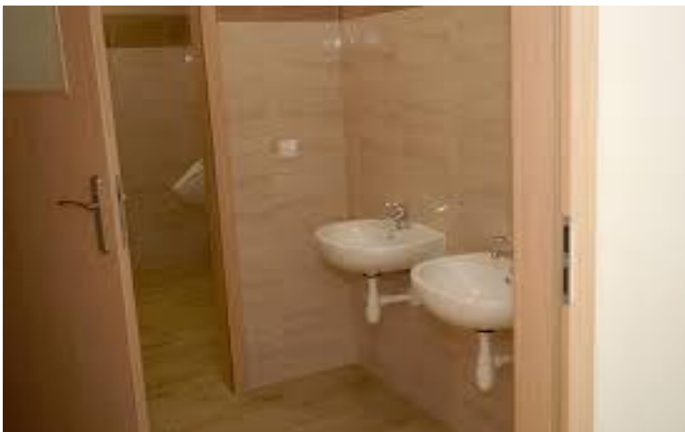
Fot. 9 węzeł sanitarny budynku administracyjnego przy ul. Panoramicznej w miejscowości Ruda
