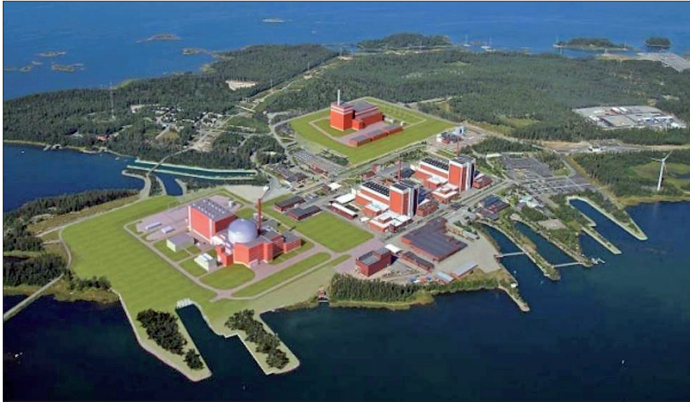
Rysunek 3. Kompleks elektrowni na wyspie Olkiluoto w Finlandii. Najbliżej z lewej – najnowszy, trzeci blok jądrowy z reaktorem Areva EPR, z prawej dwa starsze bloki 1 i 2 ze szwedzkimi reaktorami ASEA Atom BWR 880. W głębi elektrownia gazowa [TVO]
