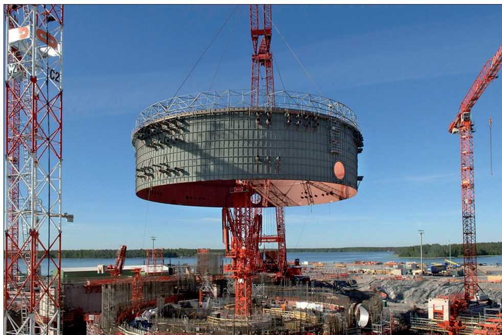
Rysunek 5. Montaż obudowy bezpieczeństwa reaktora na budowie EJ Olkiluoto 3 [Areva NP]
