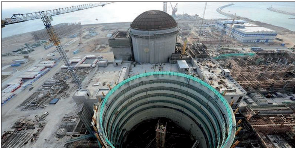
Rysunek 18. Budowa bloków 5 i 6 w EJ Fuqing, w których zastosowano chińskie reaktory typu Hualong one [China Nuclear E&C Group]
