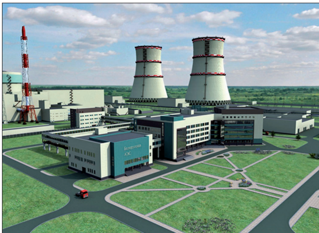
Rysunek 16. Tak docelowo wyglądać ma budowana obecnie Białoruska Elektrownia Jądrowa w Ostrowcu [Atomstrojeksport]
