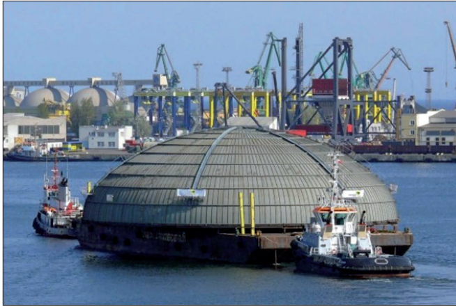
Rysunek 4. Kopuła stanowiąca zwieńczenie obudowy reaktora dla EJ Olkiluoto 3 wyprodukowana przez ENERGMONTAŻ-PÓŁNOC rozpoczyna morską podróż z Polski do Finlandii [fot. ELEKTROMONTAŻ-PÓŁNOC]
