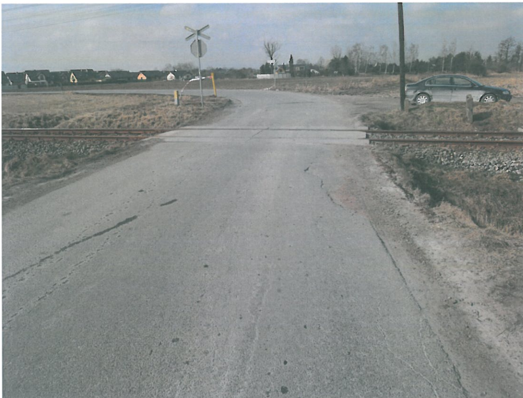
Fot. 7. Widok przejazdu z kierunku zbliżającego się samochodu
