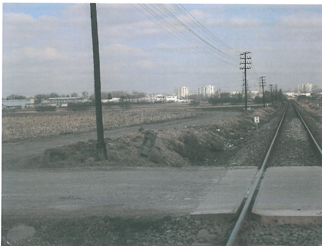
Fot. 10. Widok na drogę gruntową z prawej strony przejazdu (brak znaku F6a)
