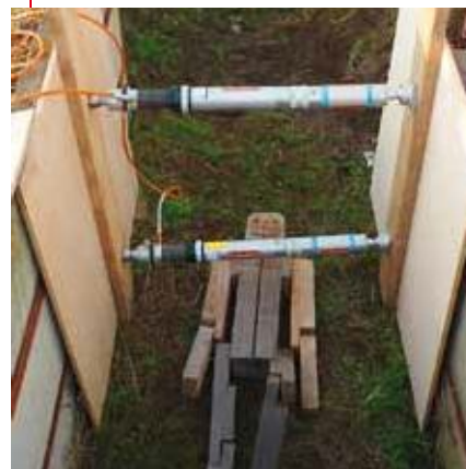
Zamontowanie pierwszej pary paneli
