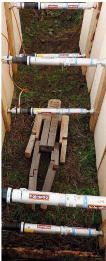
Gotowe zabezpieczenie wykopu prostego
