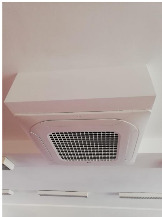
Fot. 71. Pomieszczenia komendy w trakcie instalacji urządzeń klimatyzacji
