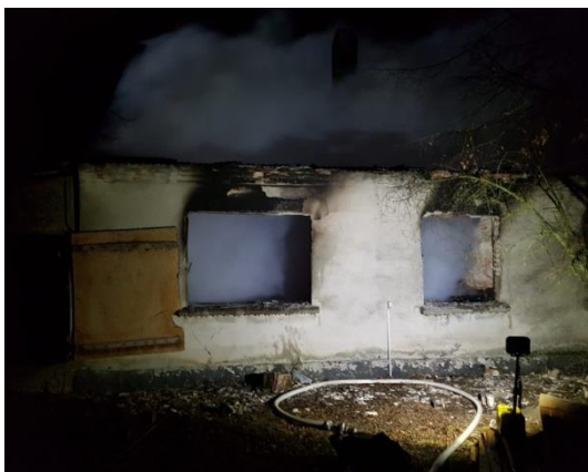
Fot. 16. Pożar budynku mieszkalnego
