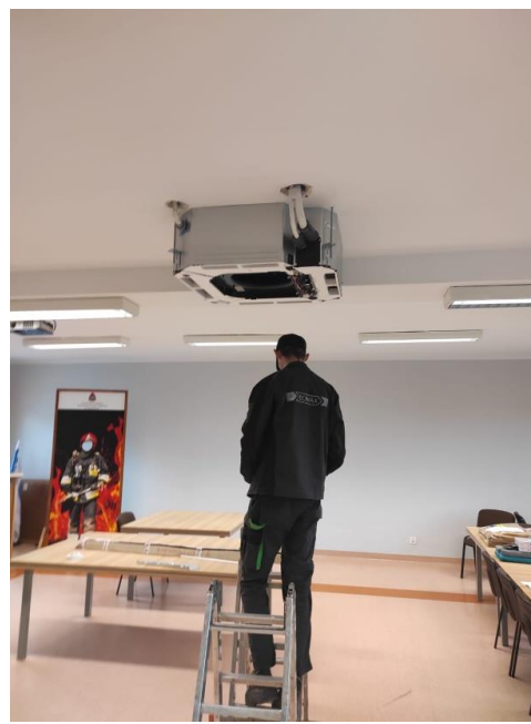
Fot. 69. Pomieszczenia komendy w trakcie instalacji urządzeń klimatyzacji
