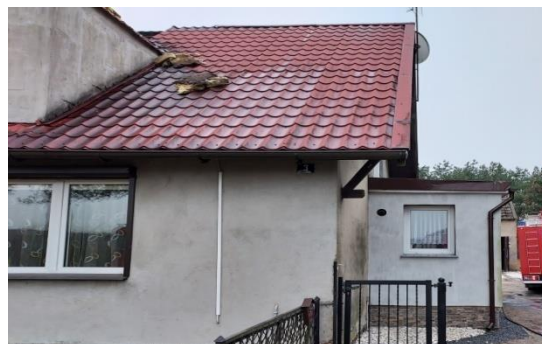
Fot. 19. Pożar budynku mieszkalnego
