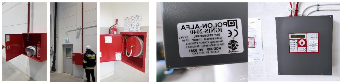
Fot. 73. Instalacje, urządzenia przeciwpożarowe
