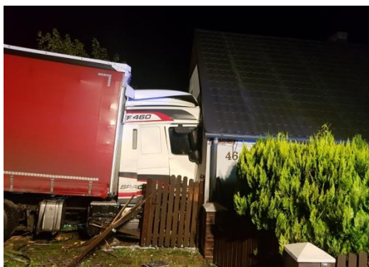
Fot. 40. Samochód ciężarowy wjechał w budynek mieszkalny
