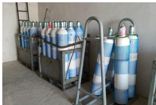
Fot. 59. Bank tlenu w Trzciance
