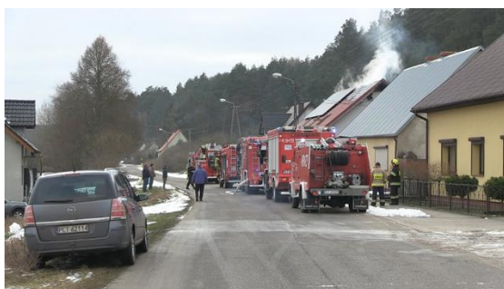
Fot. 16. Pożar domu w Radolinie
