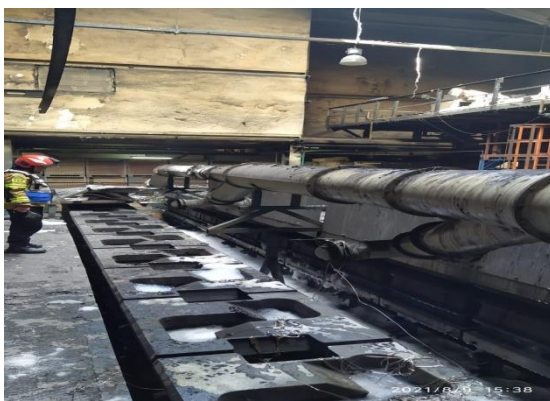
Fot. 20. Pożar w Odlewni Źeliwa
