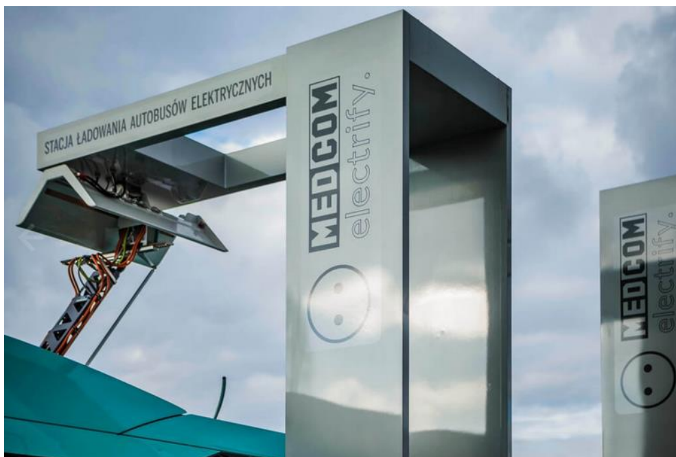
Rysunek 5. Pantografowe stacje ładowania dostarczone przez MEDCOM dla Jaworzna 44
