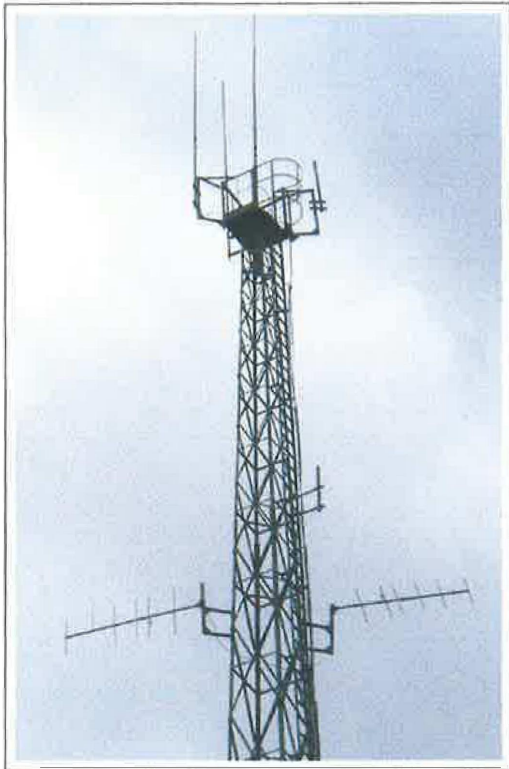
Fot. 1. Podgórze - maszt 36 m
