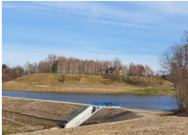
biornik nr 1 wraz z budowlą upustową
