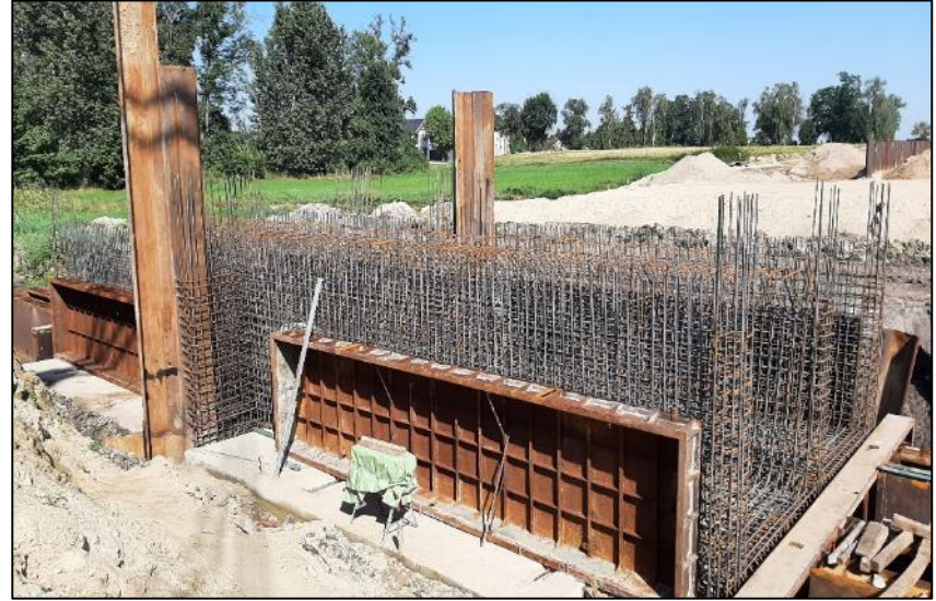
Wykonywanie konstrukcji urządzeń upustowych (sierpień 2022)
