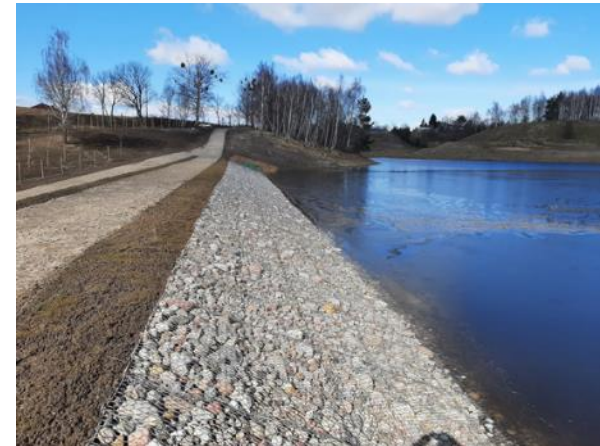
Ciąg komunikacyjny oraz ubezpieczenie skarpy zapory
