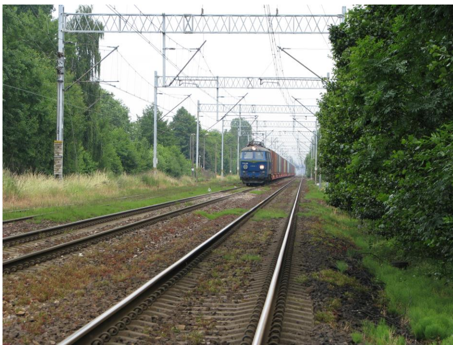
Fot. 2. Mnich, RB1. Linie kolejowe nr 93 i 157 w kierunku Chybia
