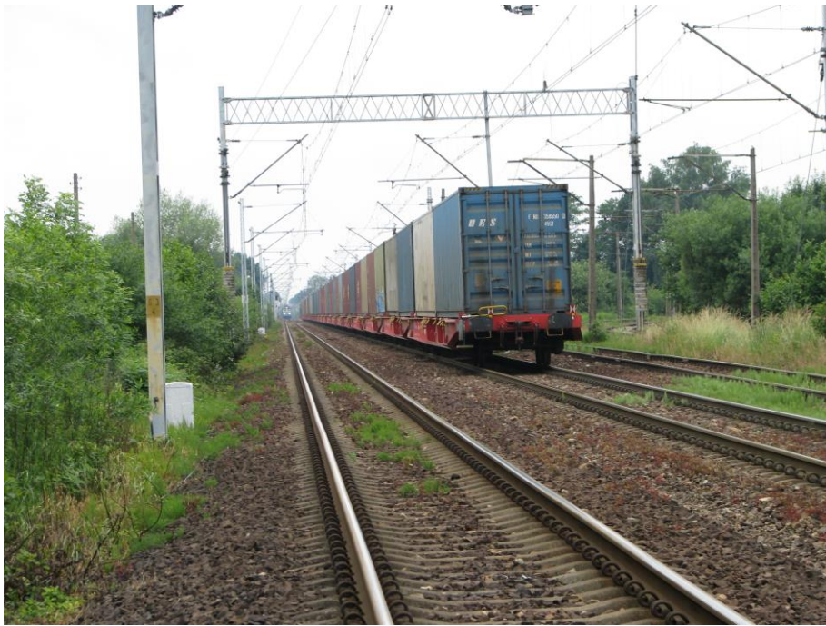
Fot. 3. Mnich, RB1. Linie kolejowe nr 93 i 157 w kierunku Zebrzydowic, Strumienia
