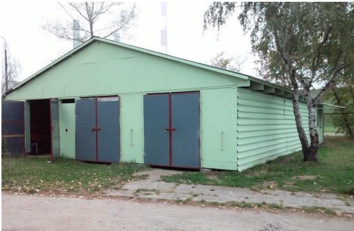
Fot. 7 Obiekty AZS AWF Warszawa.
