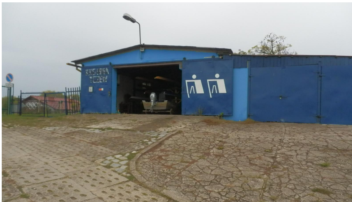
Fot. 26 Hangar na łódzie Kolejowego Klubu Sportowego "UNIA" Tczew.
