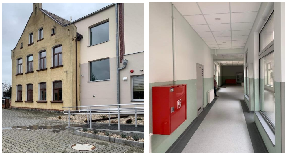
Zdjęcie nr 5: Rozbudowa Szkoły Podstawowej w Lasocicach (łącznik z zewnątrz i wewnątrz)
