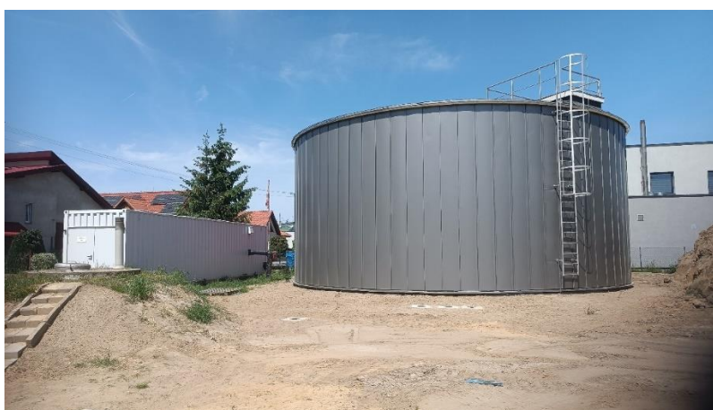
Zdjęcie nr 2: Zbiornik do gromadzenia wody uzdatnionej – stacja uzdatniania wody w Lipnie.
