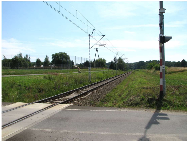
Fot. 3. Osiny, linia kolejowa nr 158 w kierunku Wodzisławia Śląskiego.
