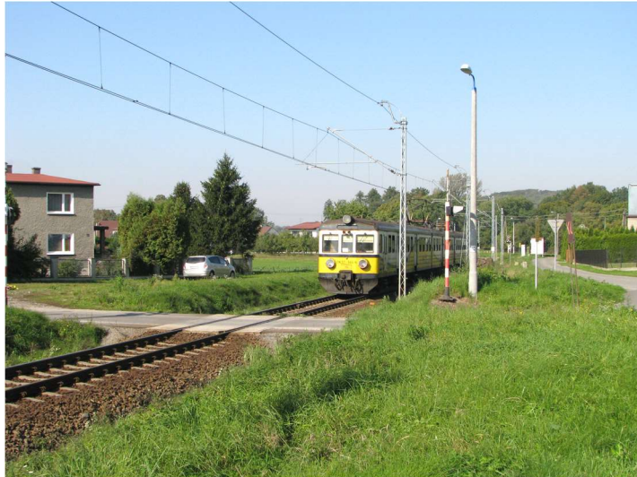
Fot. 2. Osiny, linia kolejowa nr 158 w kierunku Chałupek.
