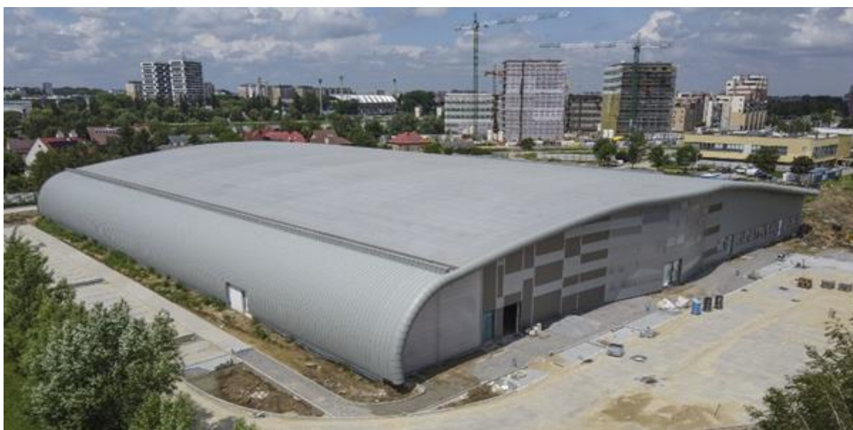
Fot. 20. Hala Podkarpackiego Centrum Lekkoatletycznego Uniwersytetu Rzeszowskiego.
