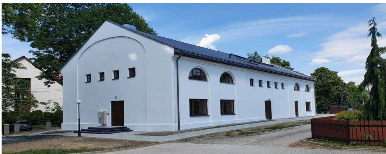
Fot. 22. Przebudowa budynku zabytkowego spichlerza na Klub Seniora w miejscowości Trzciana.
