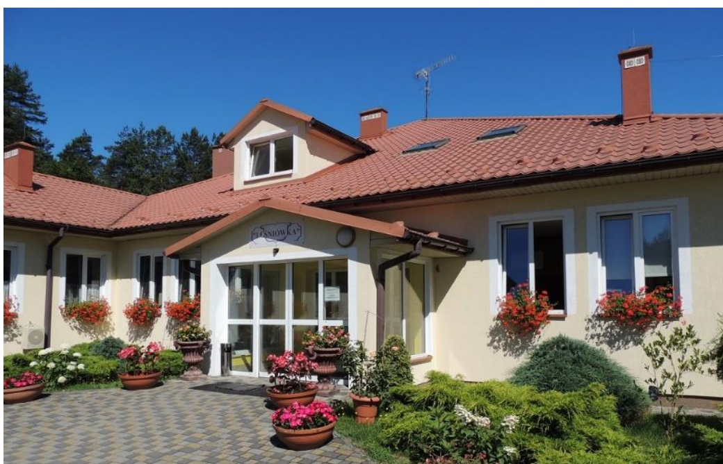
Fot. 5. Budynek Domu Spokojnej starości LEŚNIÓWKA w Turzy.
