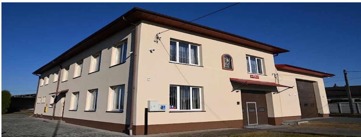
Fot. 21. Przebudowa budynku Ochotniczej Straży Pożarnej w miejscowości Lipie.
