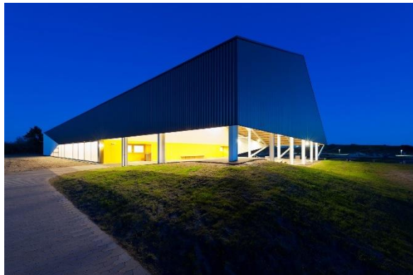
Fot. 2. Ciekawa forma, prosta, tania konstrukcja, oświetlenie dają ciekawy efekt wizualny przy minimalnych kosztach eksploatacji.
