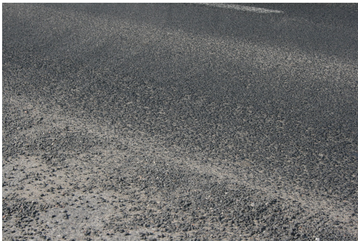
Rys. 6.11 Nawierzchnia na odcinku Korytów - km początkowy 0,000 - nawierzchnia PU (punkt D)
