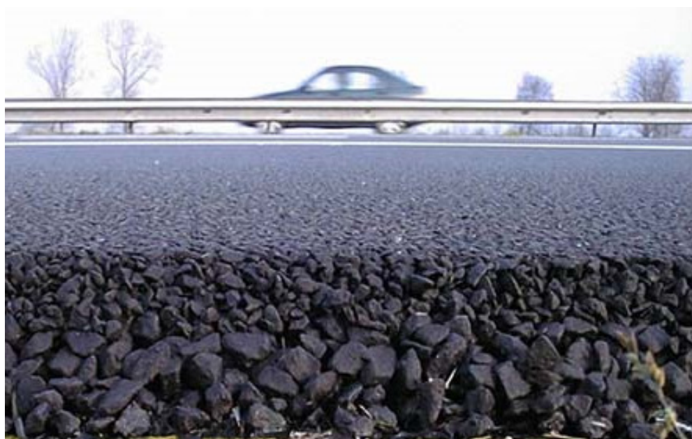
Fot. 3.12 Widok ułożonych warstw z asfaltu porowatego
