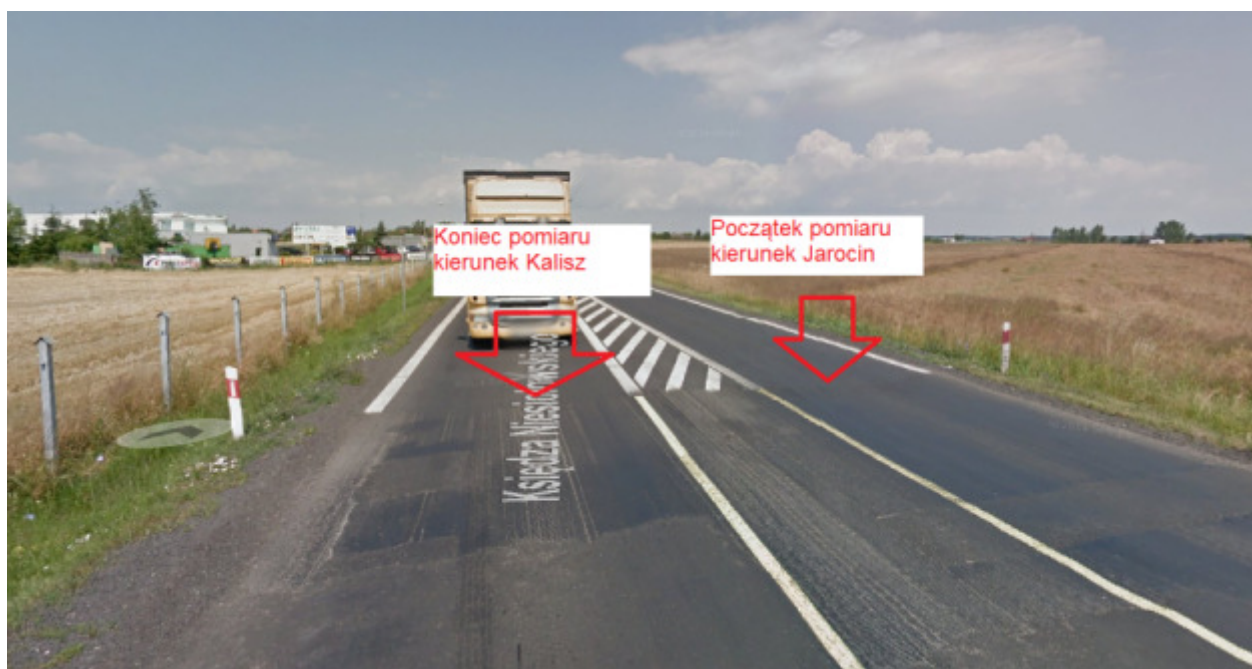
Rys. 7.50 Szczegóły związane z badaniami na odcinku 10
