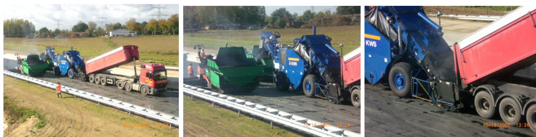
Fot. 3.8 Widok zestawu dwóch układarek z urządzeniem shuttle bugge
