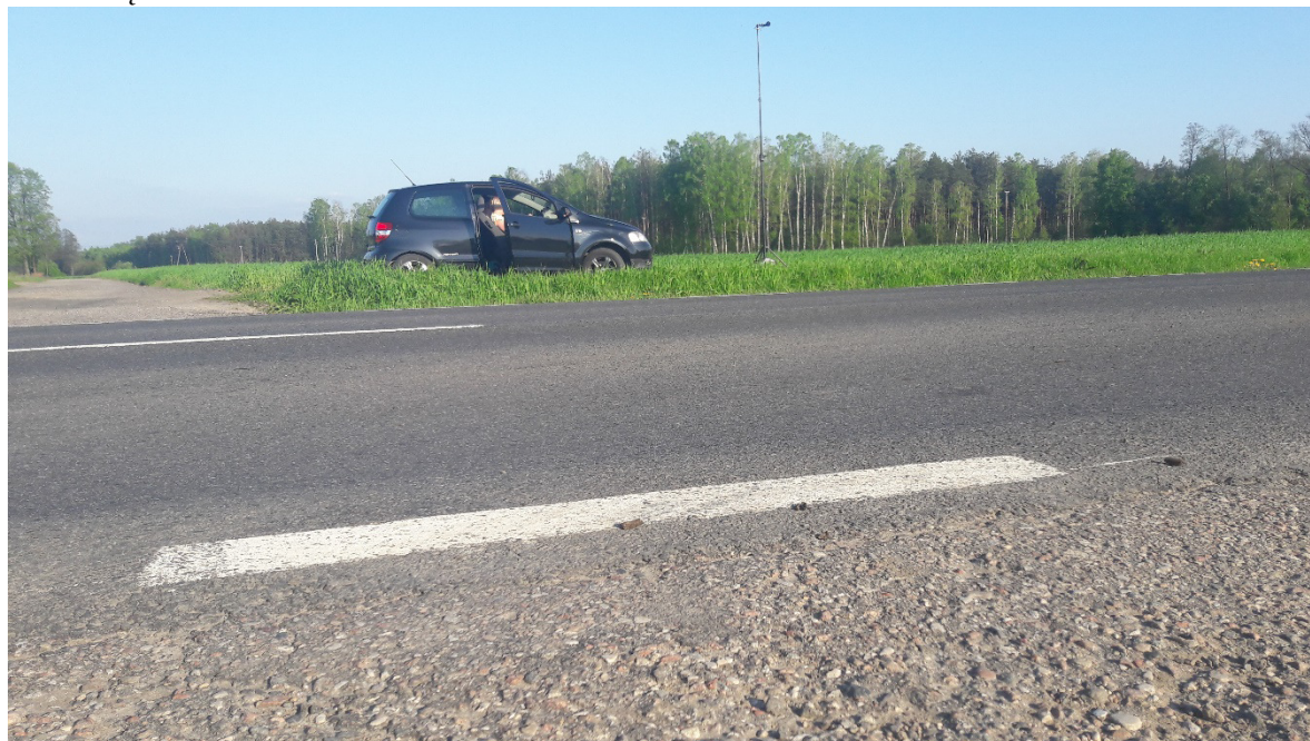
Rys. 6.10 Nawierzchnia na odcinku drogi krajowej DK-50 - km początkowy 22,000 - nawierzchnia BA (punkt A)
