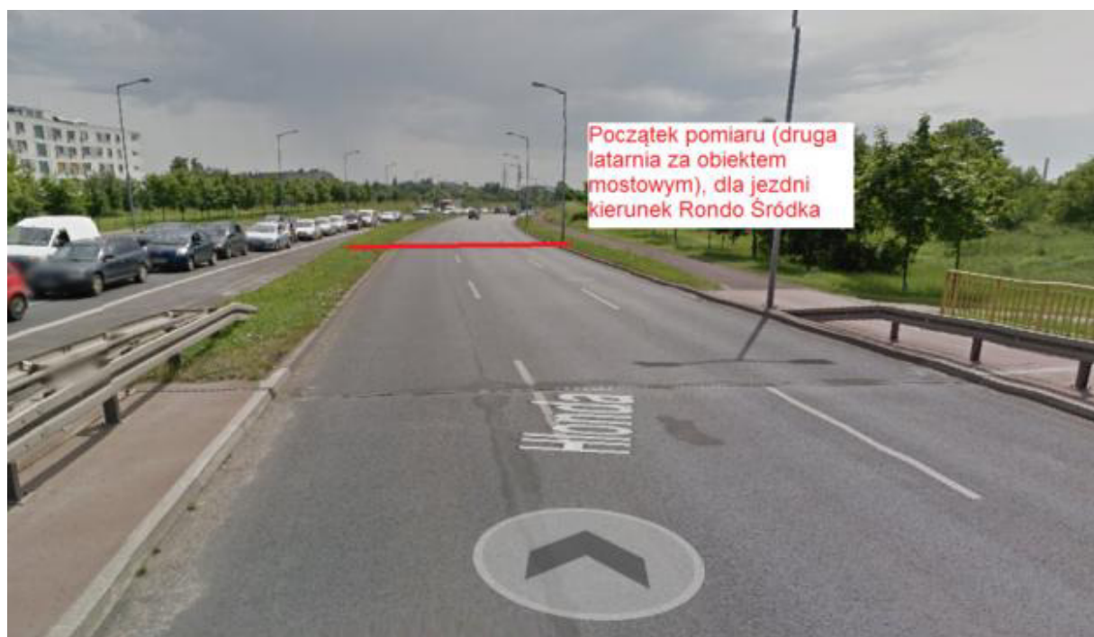
Rys. 7.40 Szczegóły związane z badaniami na odcinku 8
