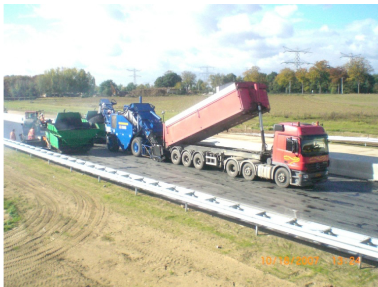
Fot. 3.10 Zestaw maszyn shuttle buggy i dwie układarki
