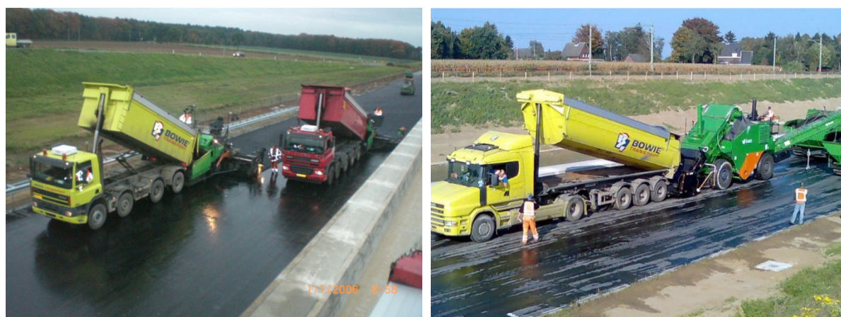
Fot. 3.4 Widok różnych zestawów a) zestaw układarki-samochody b) zestaw układarki-dodatkowy pojemnik-samochód
