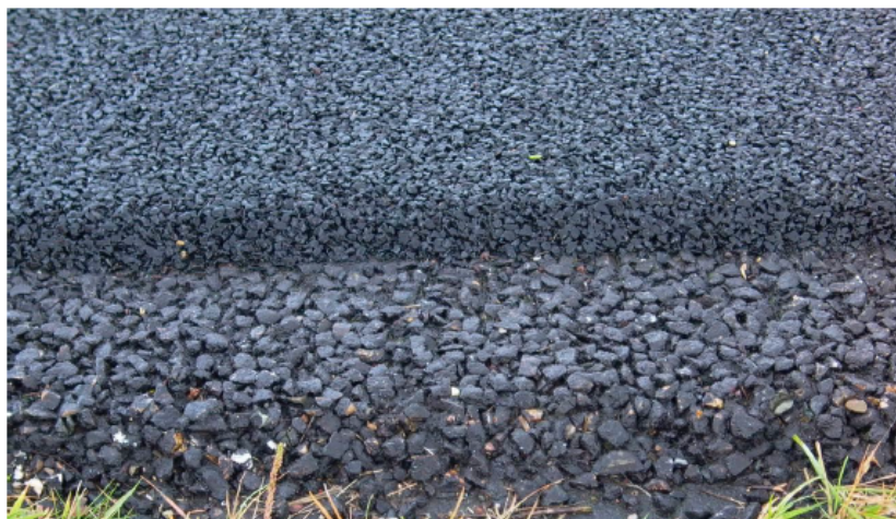
Fot. 1.4 Nawierzchnia obniżająca poziom hałasu drogowego - PA w dwóch warstwach [12]
