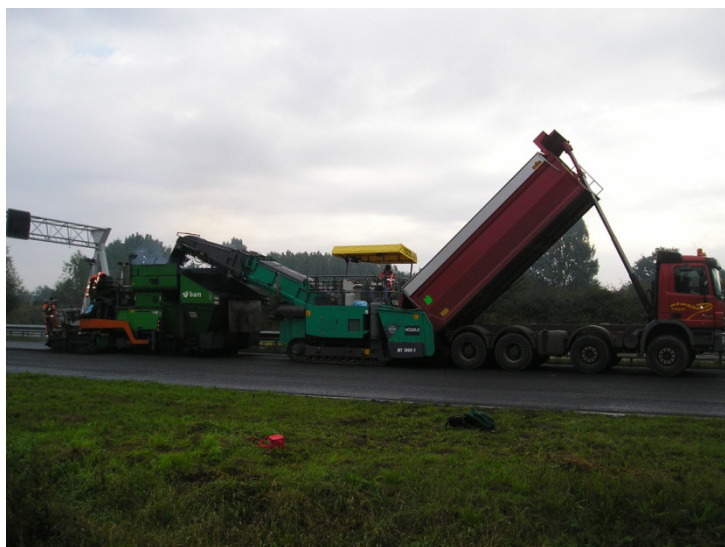
Fot. 3.11 Zestaw maszyn do układania warstw kompaktowych (układarka 1.)
