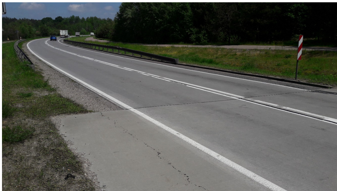
Rys. 6.12 Nawierzchnia na odcinku drogi krajowej DK-50 - km początkowy 72,800 - nawierzchnia BC (punkt E)
