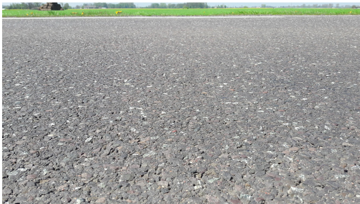
Rys. 6.14 Nawierzchnia na odcinku drogi krajowej DK-50 - km początkowy 58,000 - nawierzchnia SMA (punkt G)
