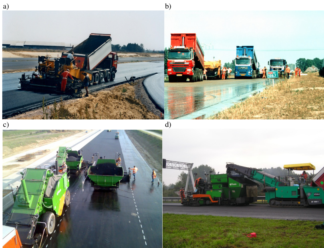
Fot. 3.5 Widok różnych zestawów maszyn do układania asfaltu porowatego a) zestaw układarka-samochód b) zestaw układarki-samochody c) zestaw dwie układarki-podajnik-samochód d) zestaw układarki z dwoma zbiornikami na mieszankę-samochód
