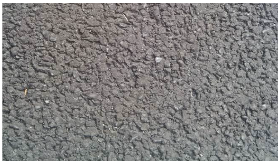
Fot. 1.2 Nawierzchnia obniżająca poziom hałasu drogowego - SMA-LA [12]
