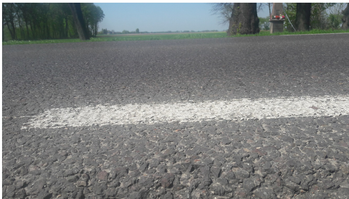
Rys. 6.13 Nawierzchnia na odcinku drogi krajowej DK-50 - km początkowy 41,500 - nawierzchnia SMA (punkt F)
