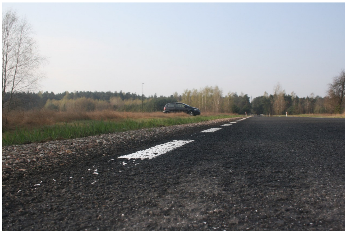
Rys. 6.17. Nawierzchnia na odcinku drogi krajowej DK-48 - km początkowy 55,000 - nawierzchnia SS (punkt J)
